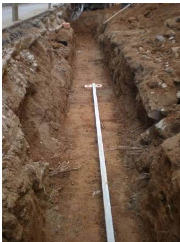
Foto 434: Final de la rasa entre E2 i E3
