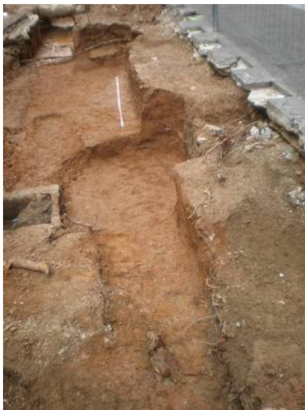
Foto 340: Després de la demolició de les riostes 118 i 122 i els pilars 116 i 120
