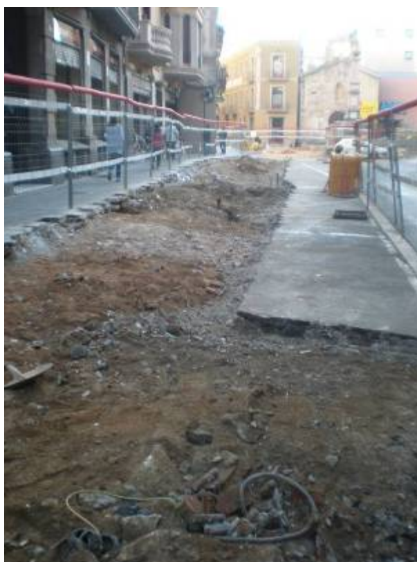
Foto 26: Després de l'extracció del paviment al carrer Sant Antoni Abat
