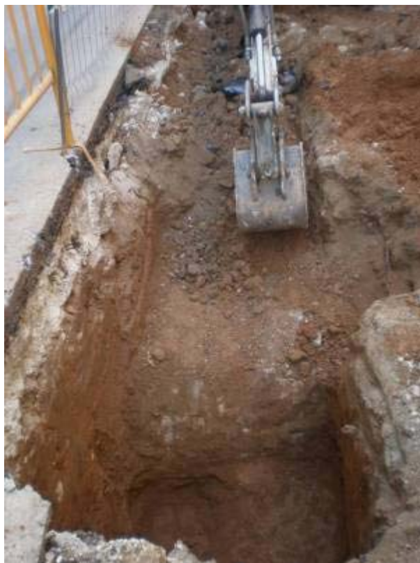
Foto 433: Excavació mecànica de la rasa entre E2 i E3
