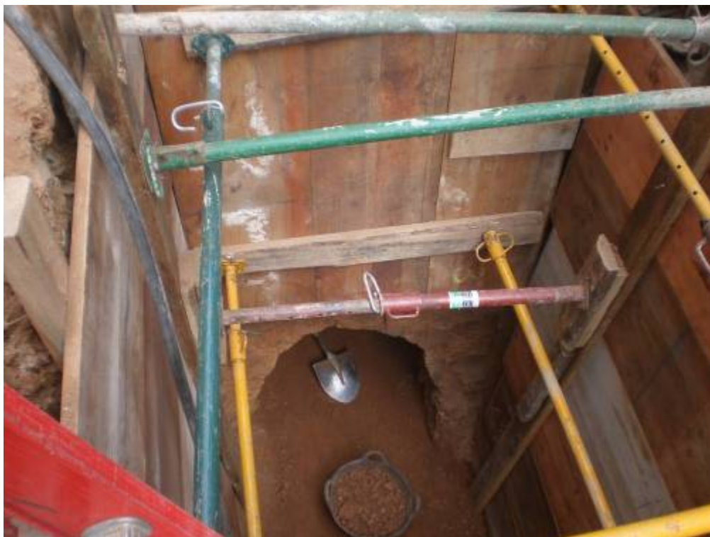
Foto 325: Boca de la mina per sota del carrer del Bisbe Laguarda. Est
