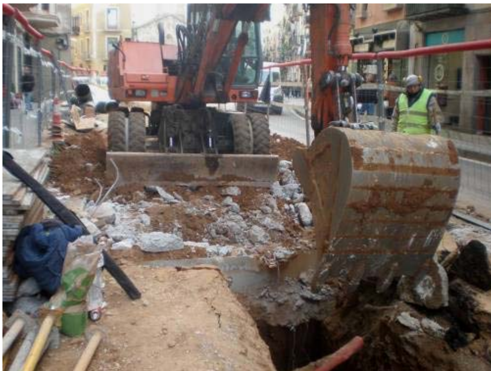
Foto 415: Excavació mecànica al búnker 2
