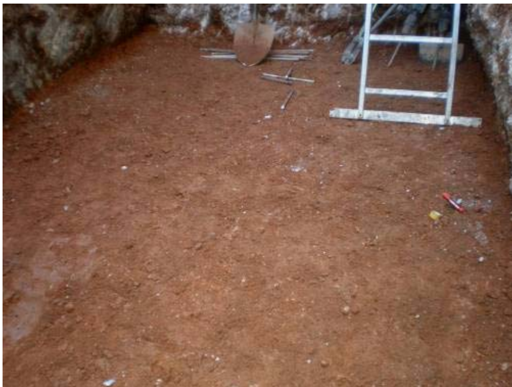
Foto 421: Final del rebaix mecànic al búnker 2. Oest
