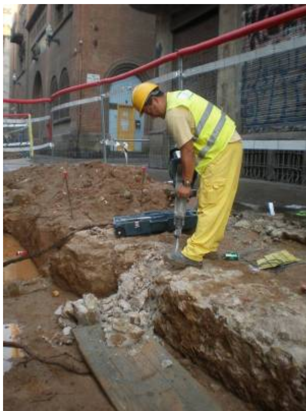
Foto 334: Demolició del mur UE 118
