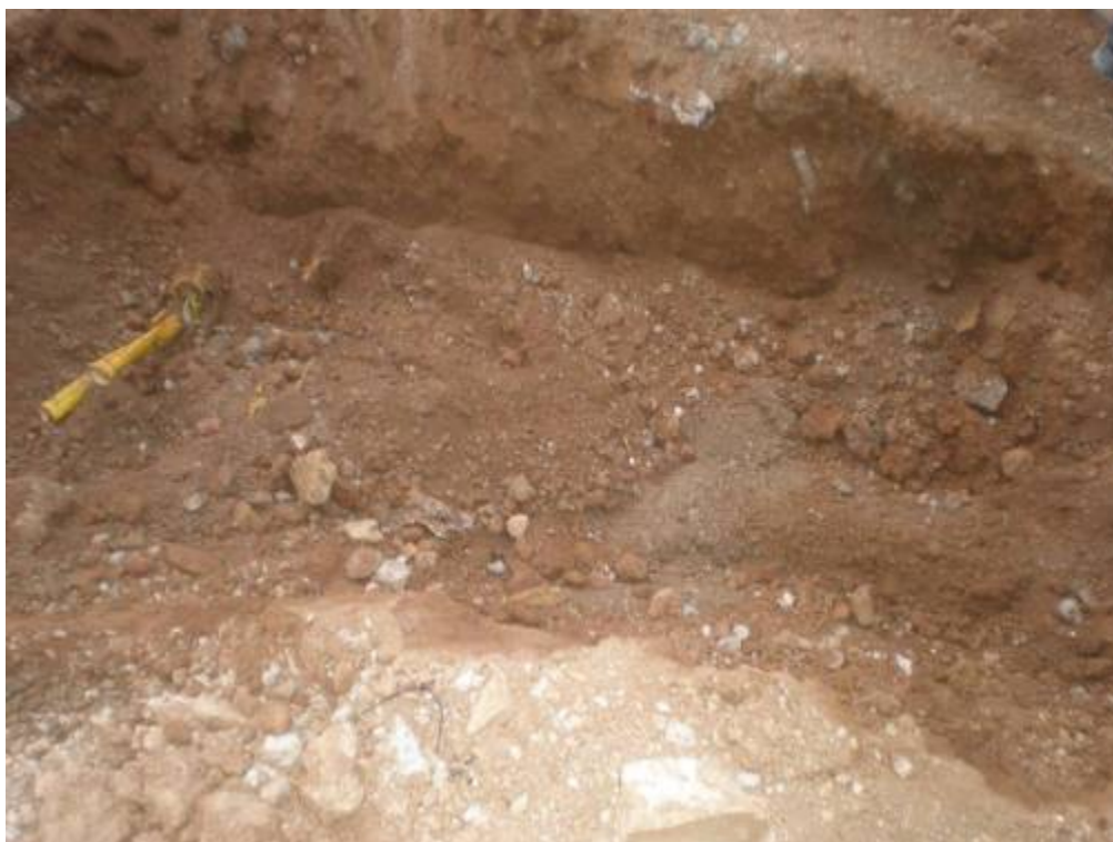
Foto 186: Excavació mecànica del tram de rasa fins búnker 2
