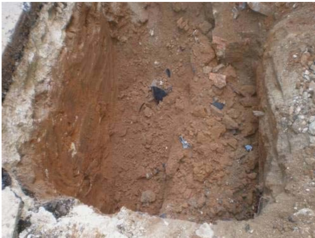
Foto 436: Excavació mecànica de l'embornal 3
