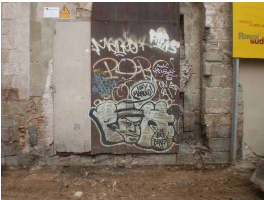
Foto 60: Detall de la fonamentació de l'església de Sant Llàtzer UE 321, a la zona de la porta
