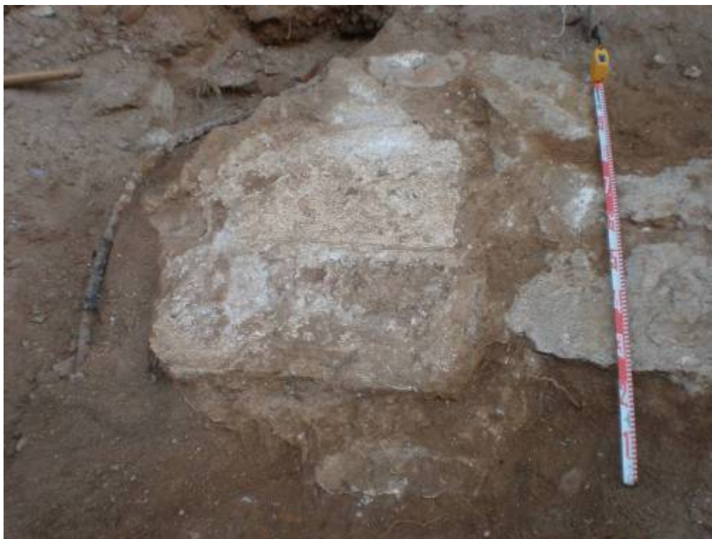
Foto 341: Pilar UE 116 amb reparacions modernes
