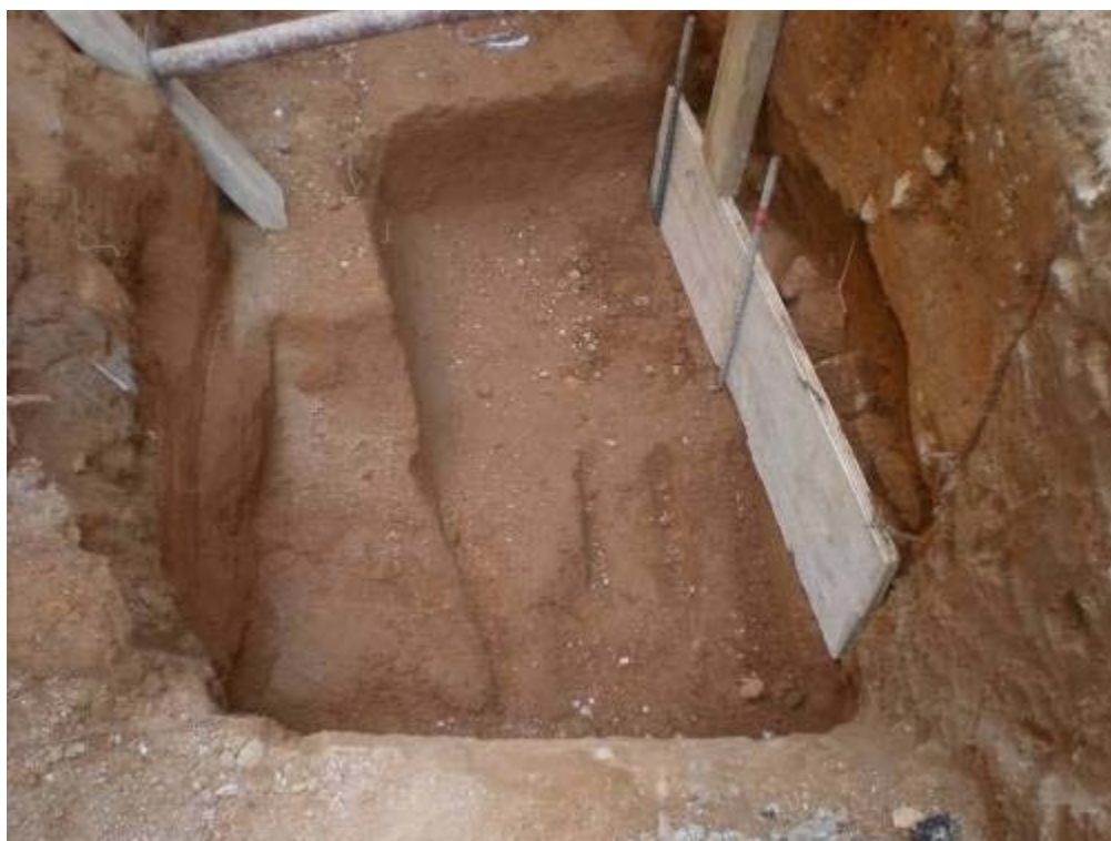
Foto 440: E3. Sistema de cobriment provisional del mur UE 337
