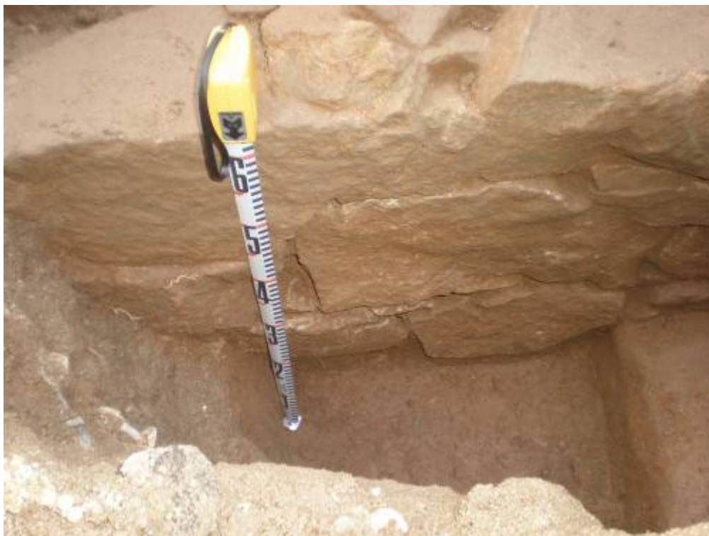
Foto 109: Detall de l'alçat sud de 288 fins a la seva fonamentació a la cota de 308
