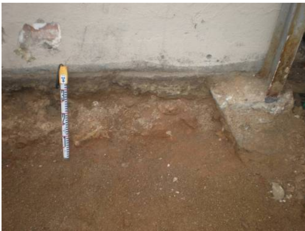
Foto 56: Detall de la fonamentació de l'església de Sant Llätzer UE 321, a la part restituïda durant els anys 90
