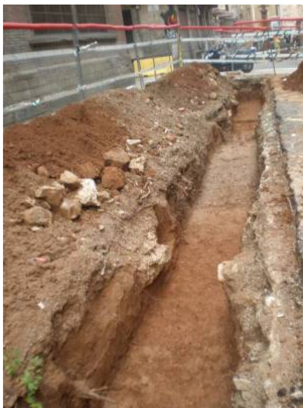
Foto 300: Excavació de la UE 195 en el tram de rasa entre el B1 i el carrer del Bisbe Laguarda. Direcció est
