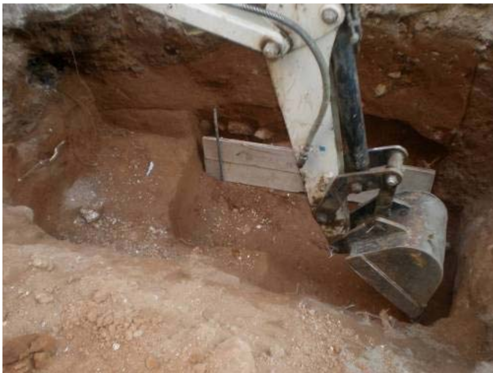
Foto 441: Continuació de les tasques d'excavació mecànica a l'E3
