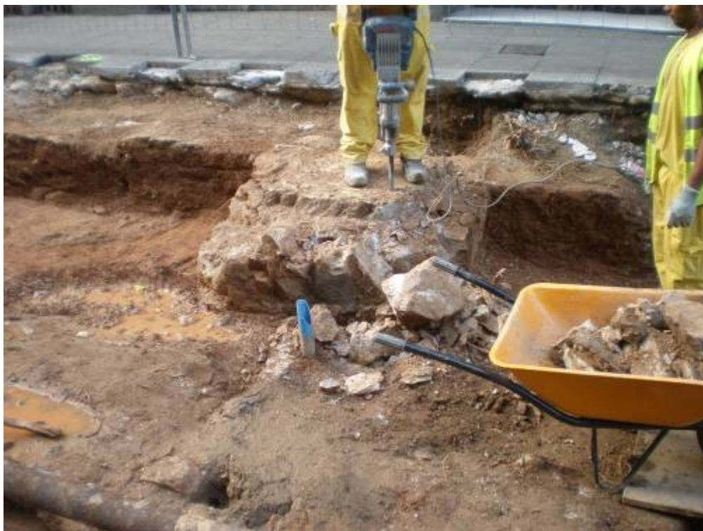
Foto 351: Demolició del pilar UE 120
