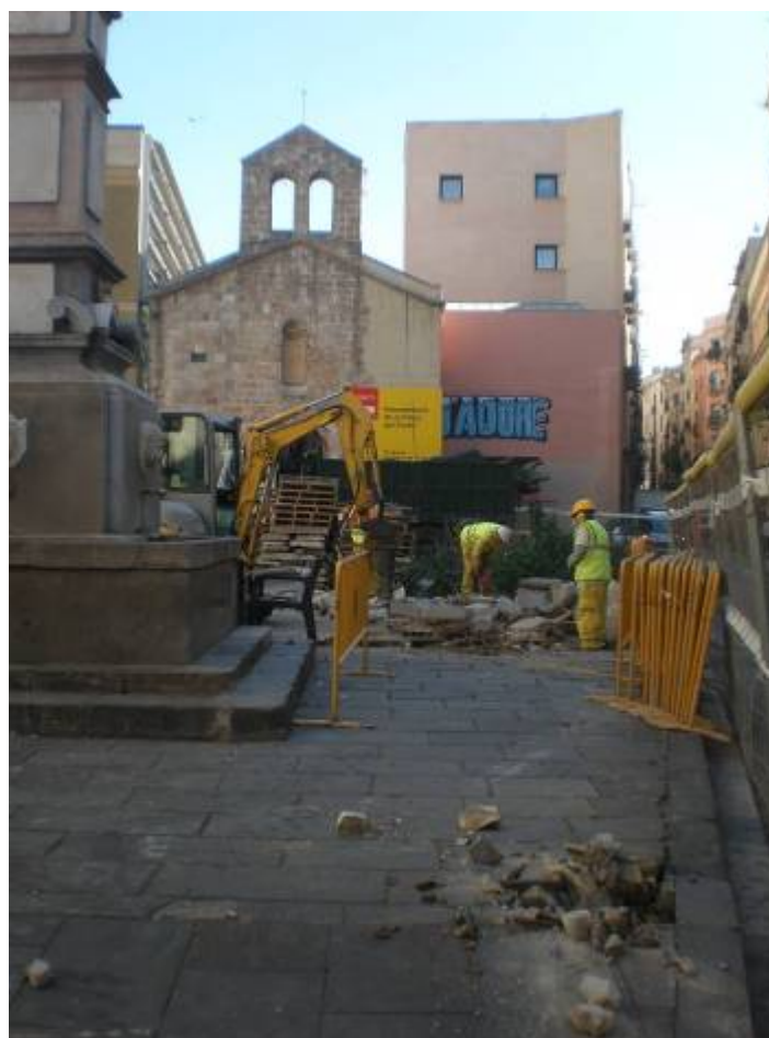
Foto 18: Extracció del paviment
