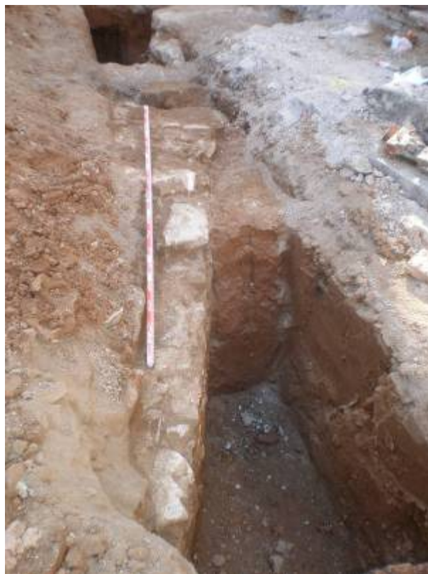
Foto 138: Mur de claveguera UE 159
