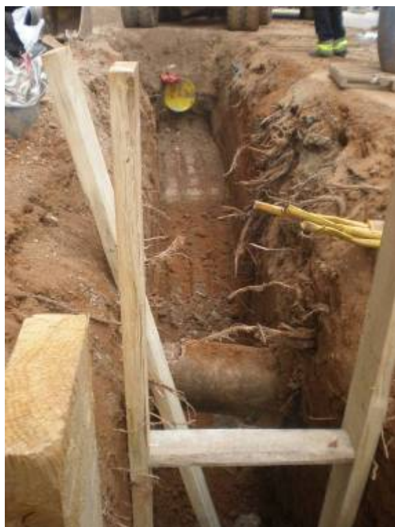
Foto 190: Punt d'enllaç amb el tram de canalització ja instal·lada
