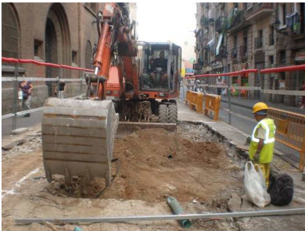
Foto 191: Inici del rebaix mecànic
