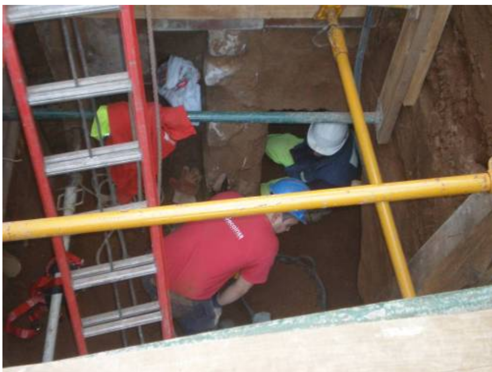
Foto 324: Procés de minat per sota del carrer del Bisbe Laguarda
