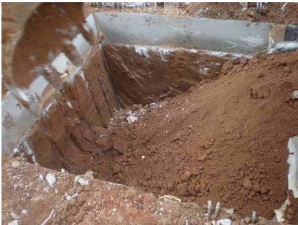
Foto 416: Excavació mecànica al búnker 2. Nord
