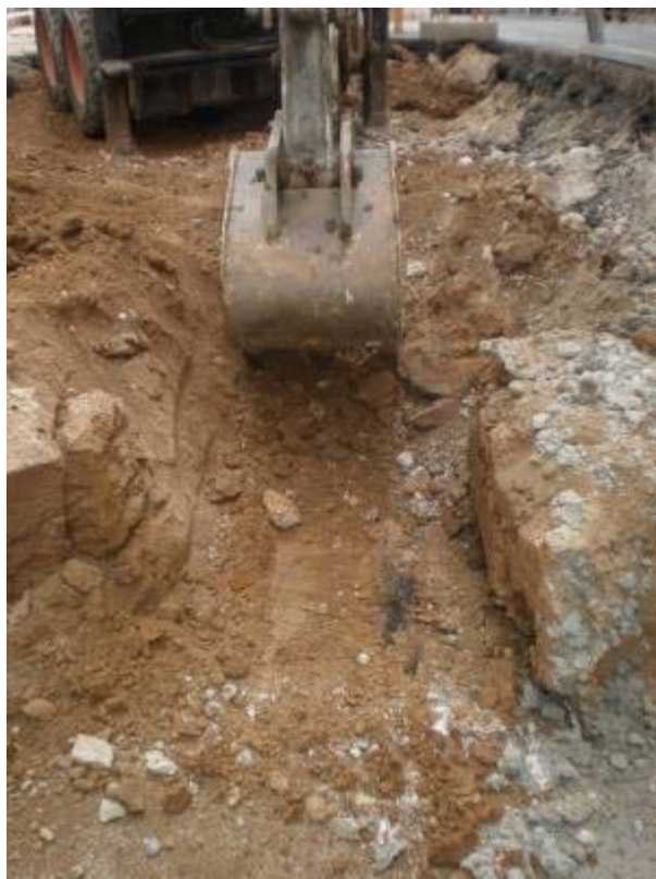
Foto 505: Excavació mecànica de la rasa entre E6 i E6a
