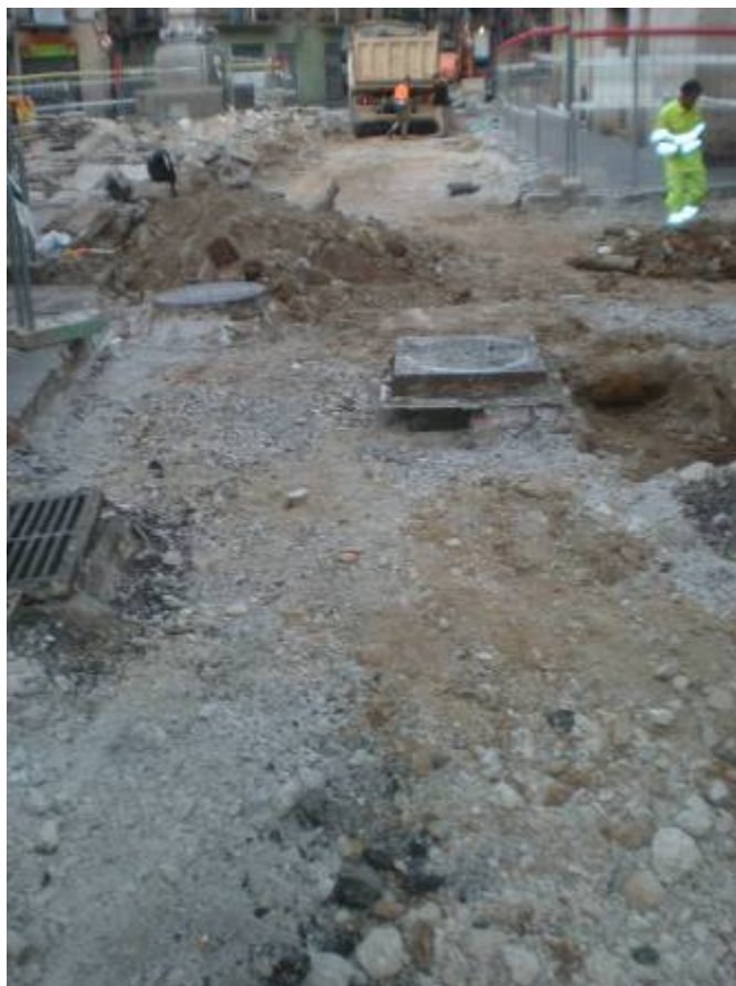
Foto 19: Retirada del paviment
