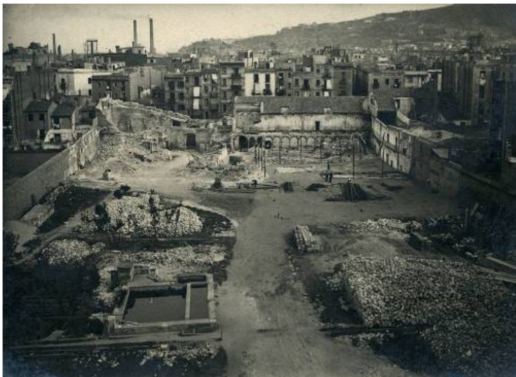
Foto 3: Reconstrucció del convent de les Jerònimes, 1911. F. Ballell (AFB)
