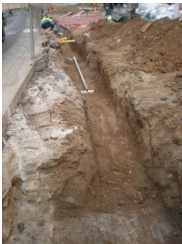
Foto 490: Final de la rasa entre E5 i E6
