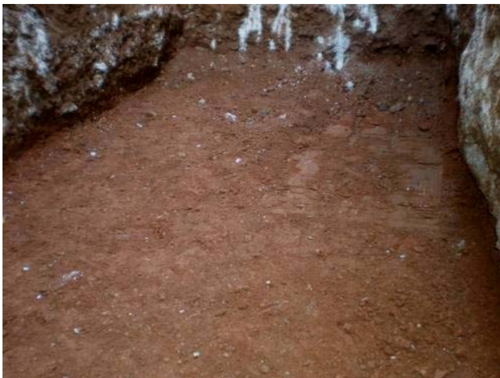
Foto 420: Final del rebaix mecànic al búnker 2. Est
