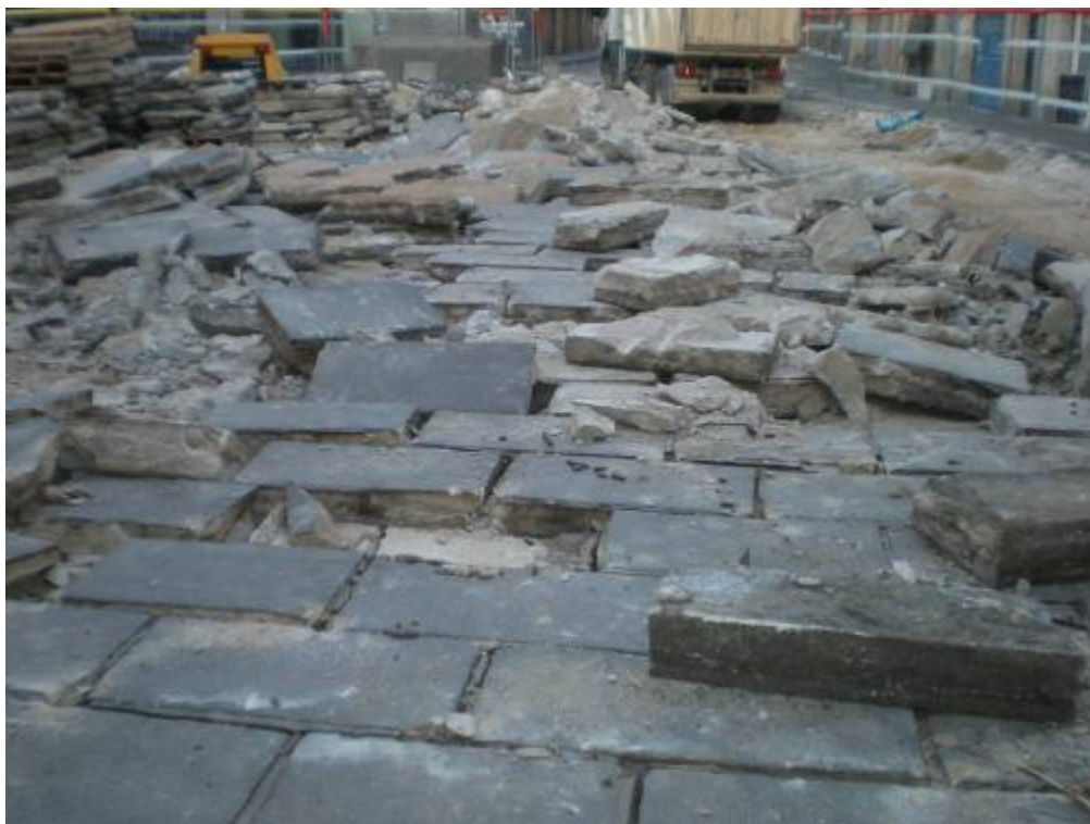
Foto 21: Retirada del paviment
