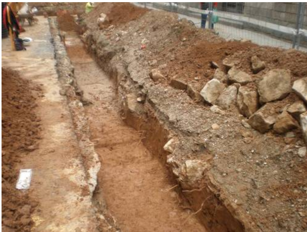
Foto 301: Excavació de la UE 195 en el tram de rasa entre el B1 i el carrer del Bisbe Laguarda. Direcció oest
