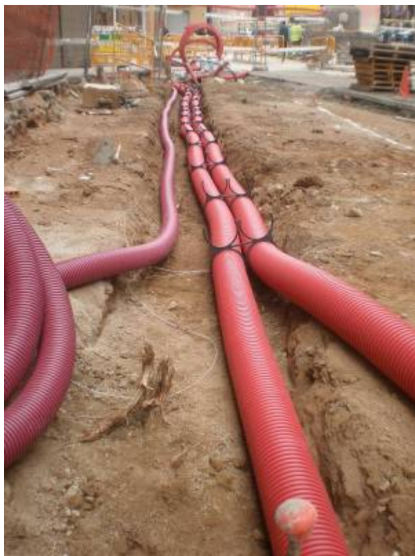
Foto 524: Final de la rasa d'electricitat
