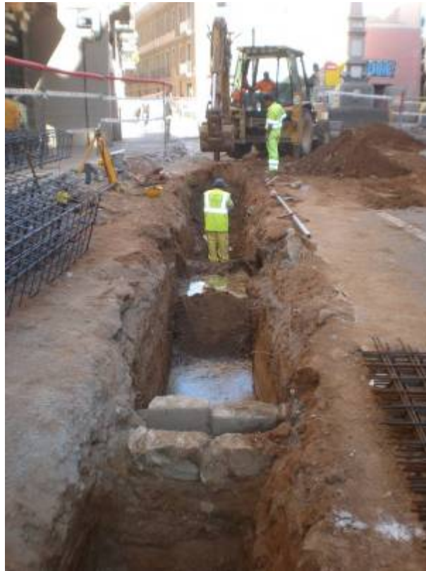
Foto 137: Tram de rasa amb localització de la UE 150
