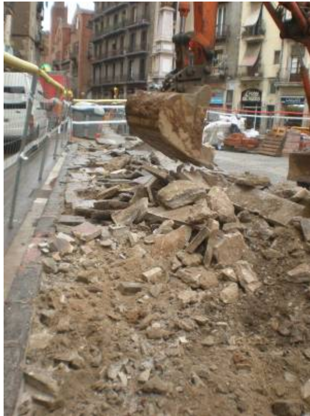
Foto 89: Extracció del paviment de la plaça al sector sud
