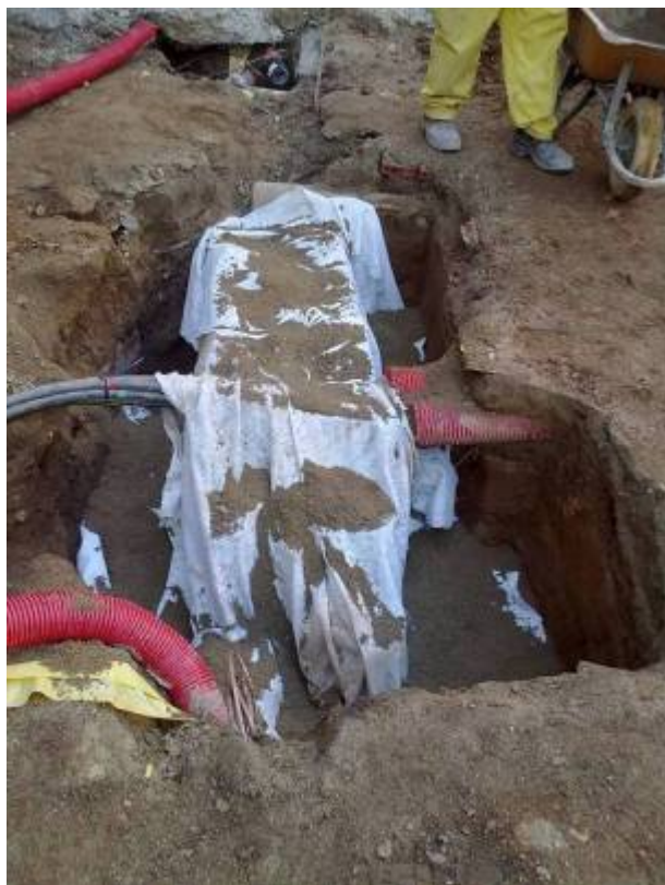
Foto 119: Cobriment del mur UE 288
