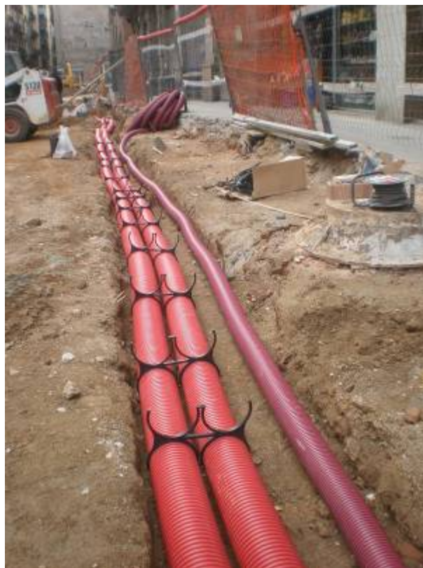
Foto 531: Final de la rasa d'electricitat. Oest
