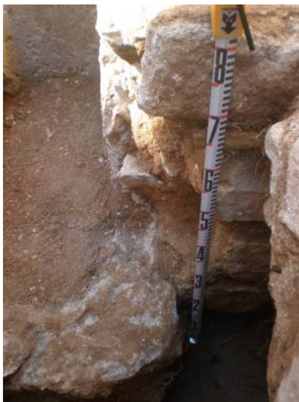
Foto 200: Alçat est del mur UE 172 amb afectació per l'embornal UE 171
