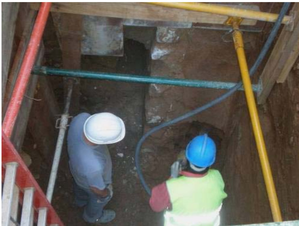
Foto 321: Inici del procés de minat per sota del carrer del Bisbe Laguarda. Oest
