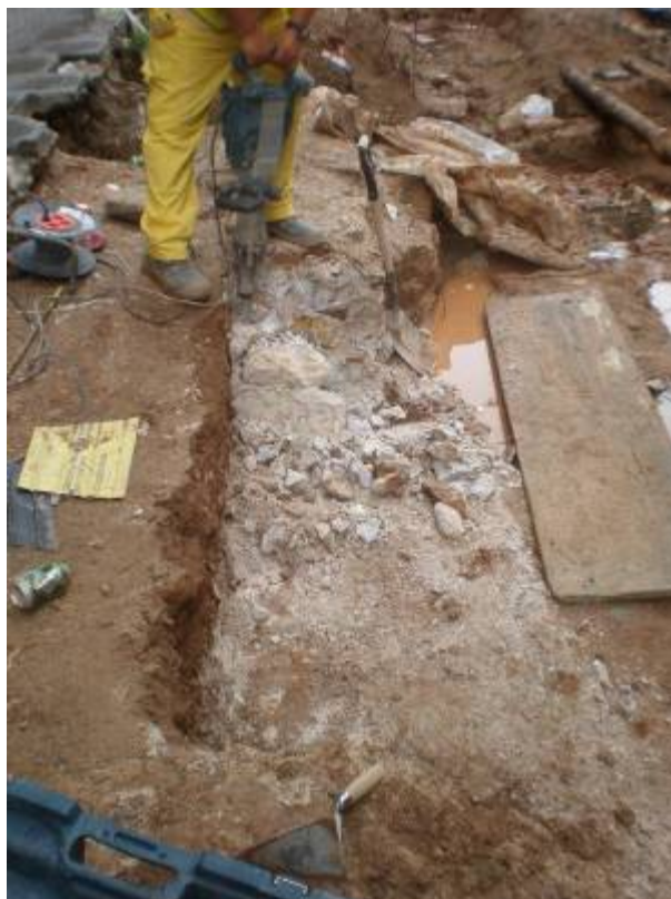
Foto 335: Demolició del mur UE 118
