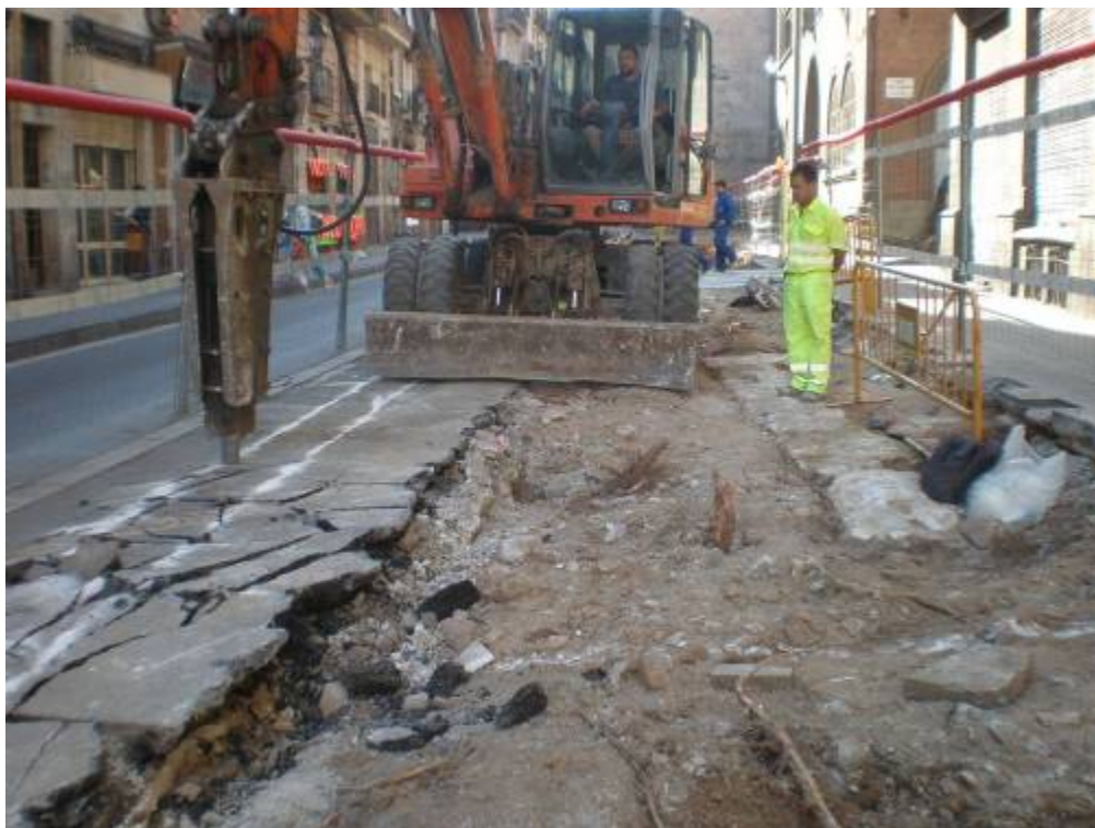
Foto 329: Demolició de part del paviment. A la dreta hi ha les restes del convent
