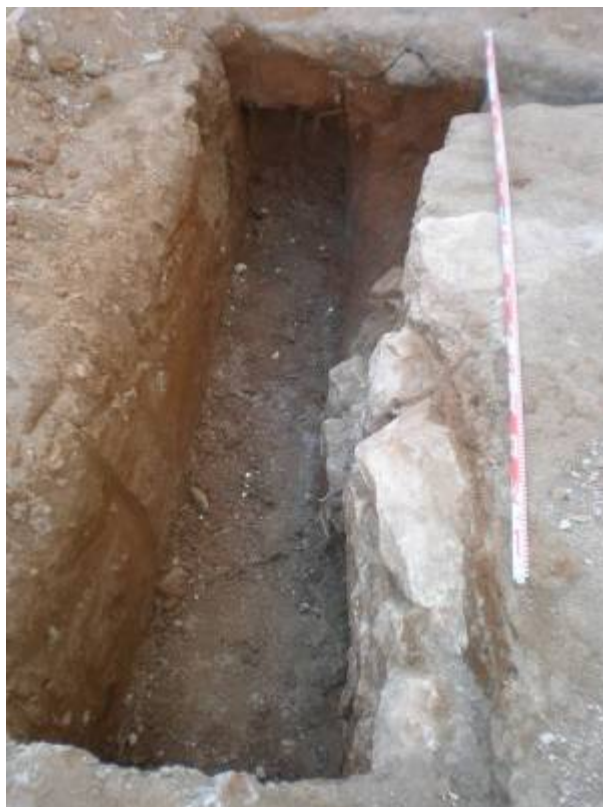
Foto 139: Mur de claveguera UE 159
