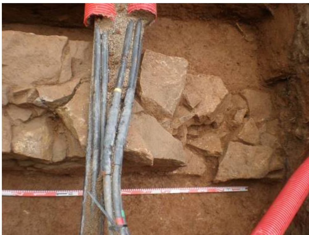
Foto 108: Detall de la cara sud del mur UE 288
