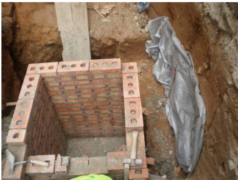
Foto 476: E3. Cobriment definitiu del mur UE 337 amb embornal en construcció
