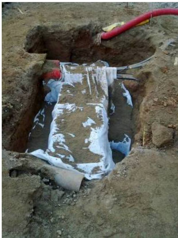
Foto 120: Cobriment del mur UE 288
