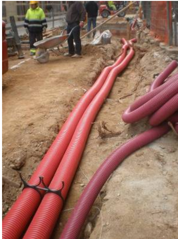
Foto 530: Final de la rasa d'electricitat. Oest
