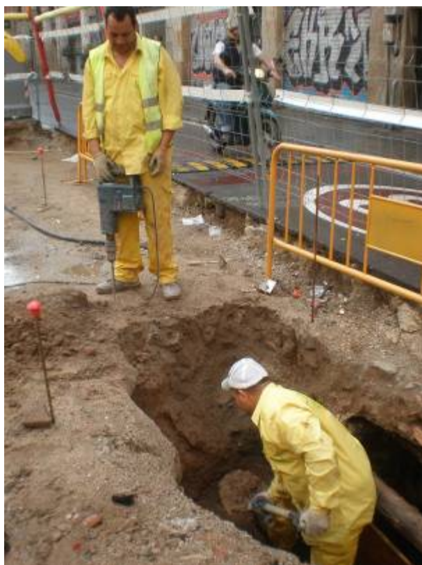
Foto 74: Excavació amb peonada de l'embornal 7 al sector sud de la plaça
