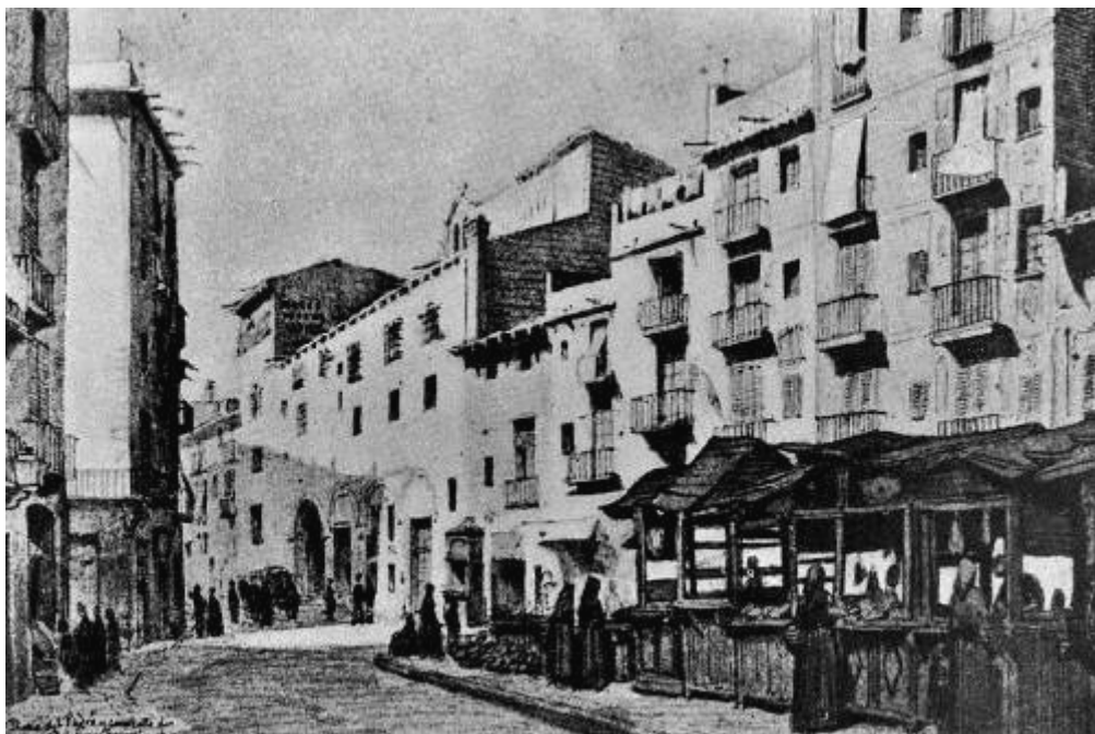
Foto 9: Façana del convent de les Jerònimes des de la plaça del Pedró. Dibuix de Lluís Rigalt realitzat entre 1860-1870. Font: RACBASJ, Reial Acadèmia Catalana de Belles Arts de Sant Jordi
