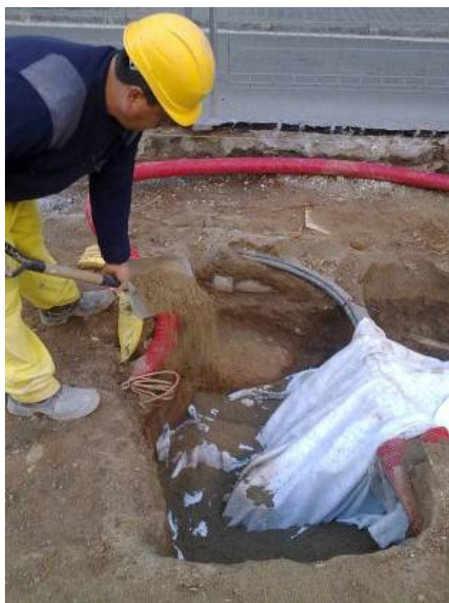
Foto 118: Cobriment del mur UE 288
