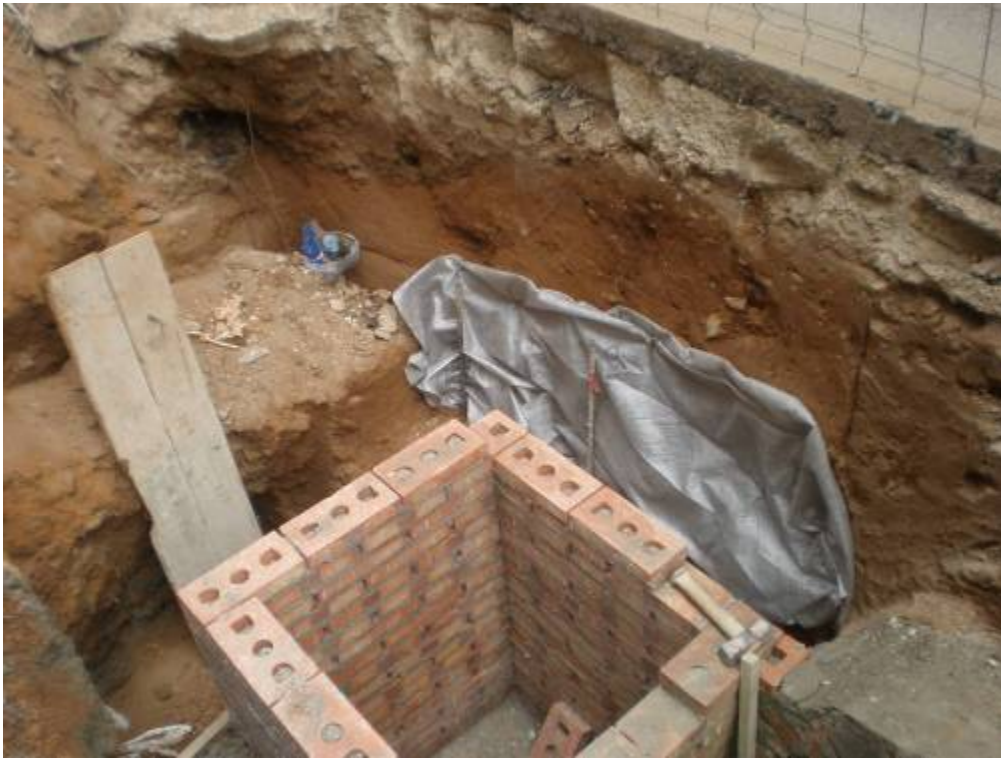
Foto 477: E3. Cobriment definitiu del mur UE 337 amb embornal en construcció
