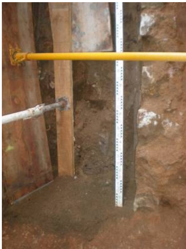
Foto 277: Absència de solera. L'amortització 206 es diposita per sobre del torturà.
