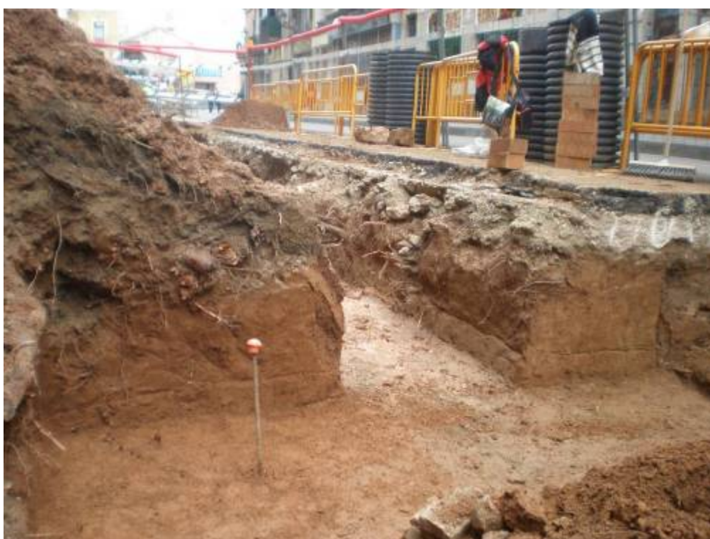
Foto 304: Final de l'excavació manual de la UE 195 des del Búnker 1 en direcció est
