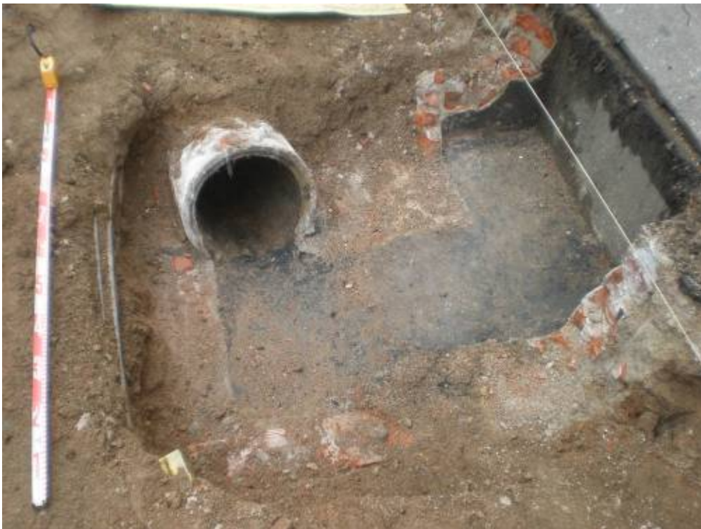
Foto 92: Obertura per a la col·locació del nou embornal. Sense afectació
