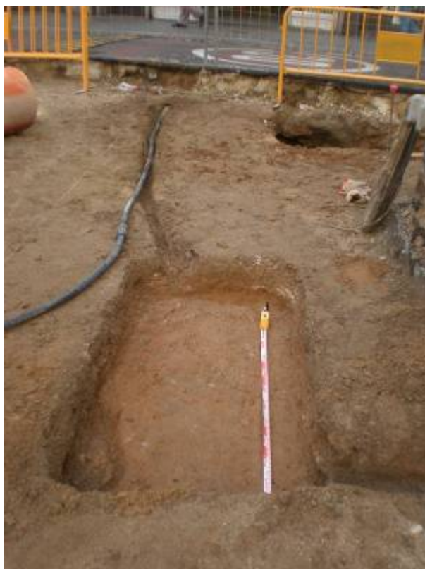
Foto 86: Obertura per a la millora de l'enllumenat al sector sud de la plaça. Negativa
