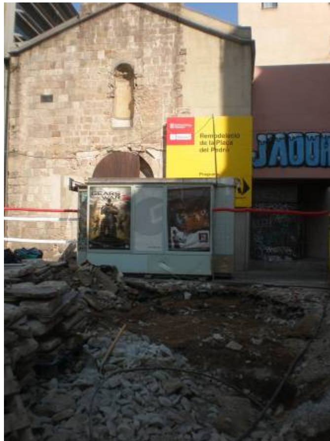
Foto 24: Extracció del paviment a la plaça del Pedró
