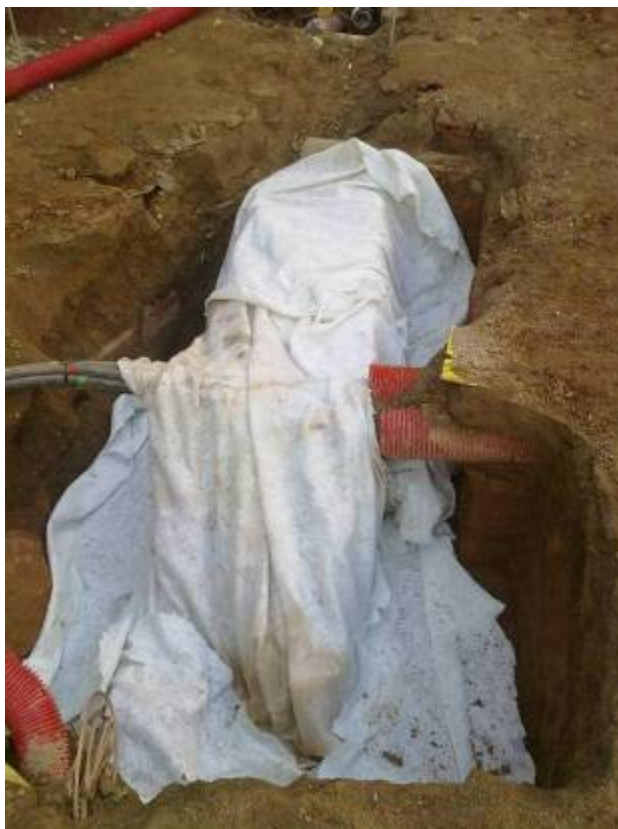
Foto 115: Cobriment del mur UE 288
