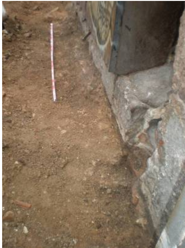
Foto 57: Fonamentació de l'església de Sant Llätzer UE 321 a la zona de la porta
