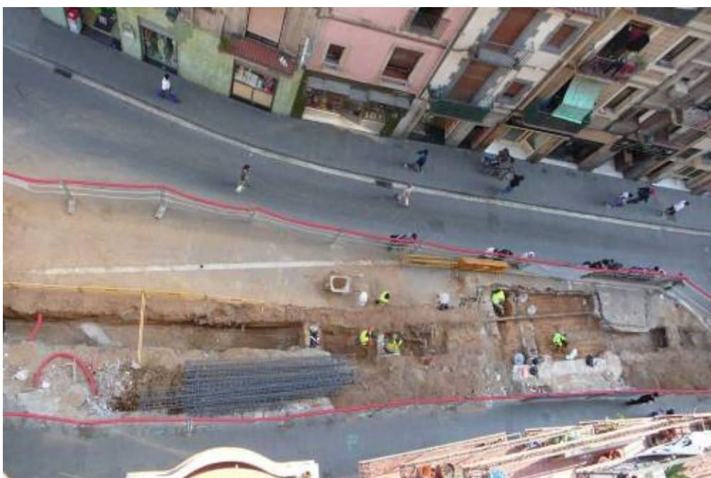
Foto 182: Vista general del tram de rasa i búnker 2
