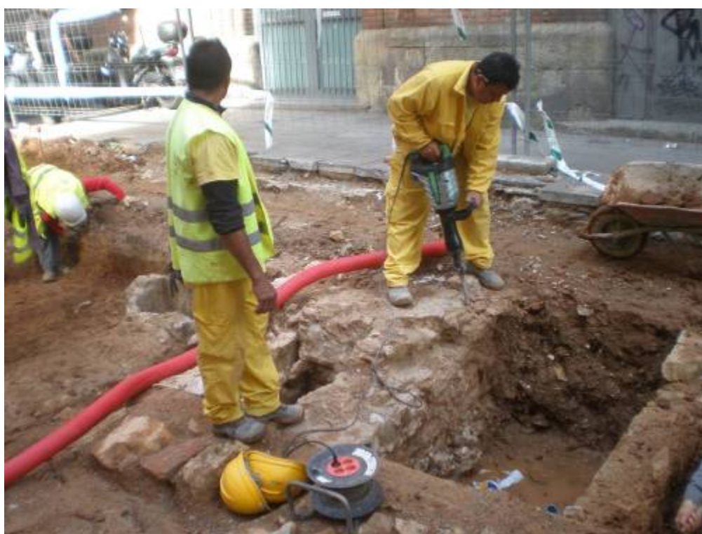
Foto 230: Demolició de la UE 176
