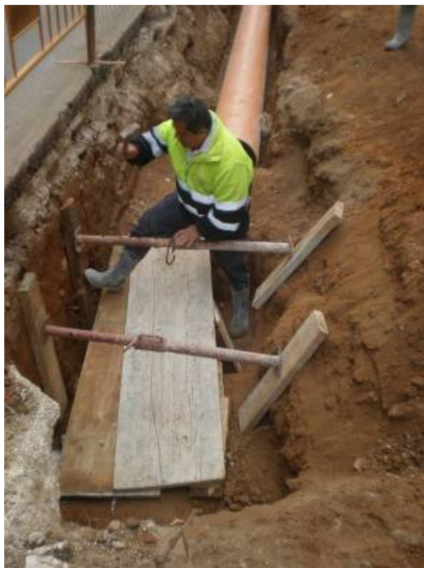
Foto 439: E3. Cobriment provisional de la UF 7 i apuntament
