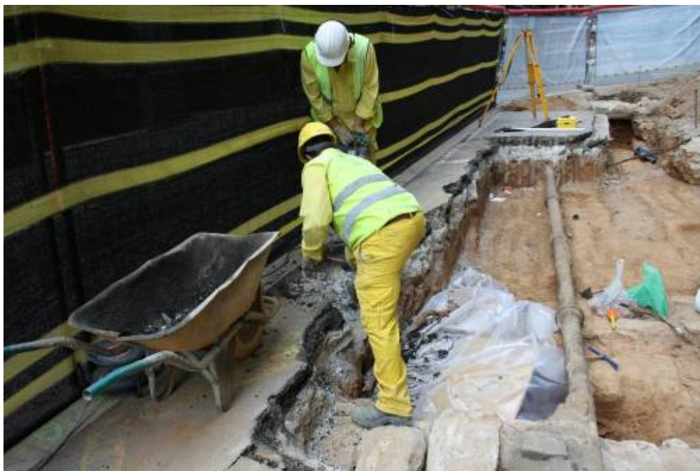
Foto 399: Tasques d'ampliació de la UF 2 que van permetre detectar la UF 4
