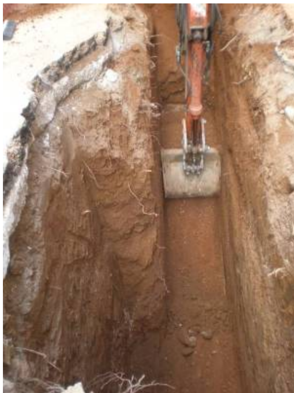
Foto 315: Procés d'excavació del tram de rasa entre el carrer del Bisbe Laguarda i el B1. Direcció oest
