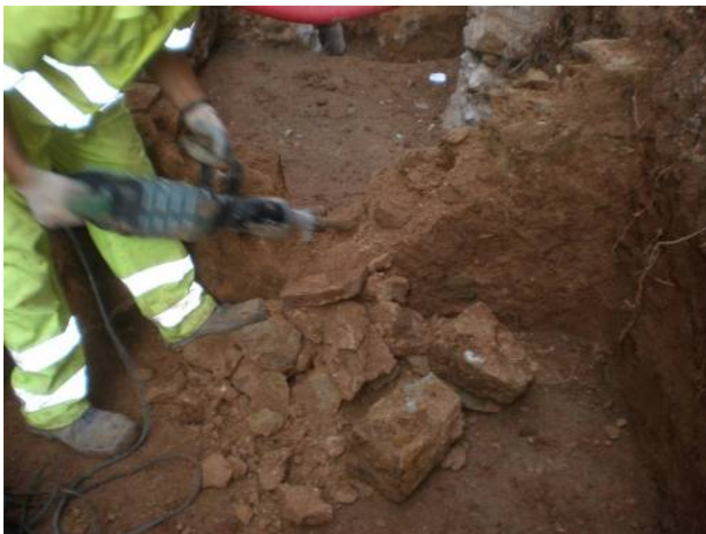
Foto 234: Demolició del mur UE 141
