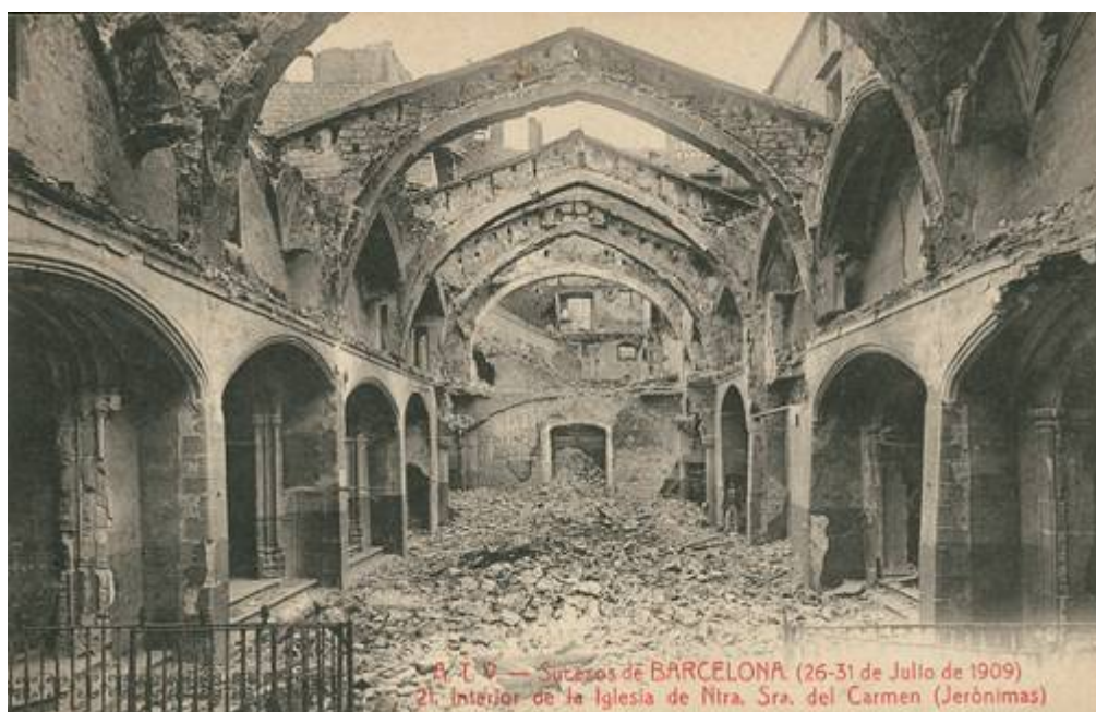
Foto 6: Interior de l'església del convent de les Jerònimes el 1909. A.T.V.
