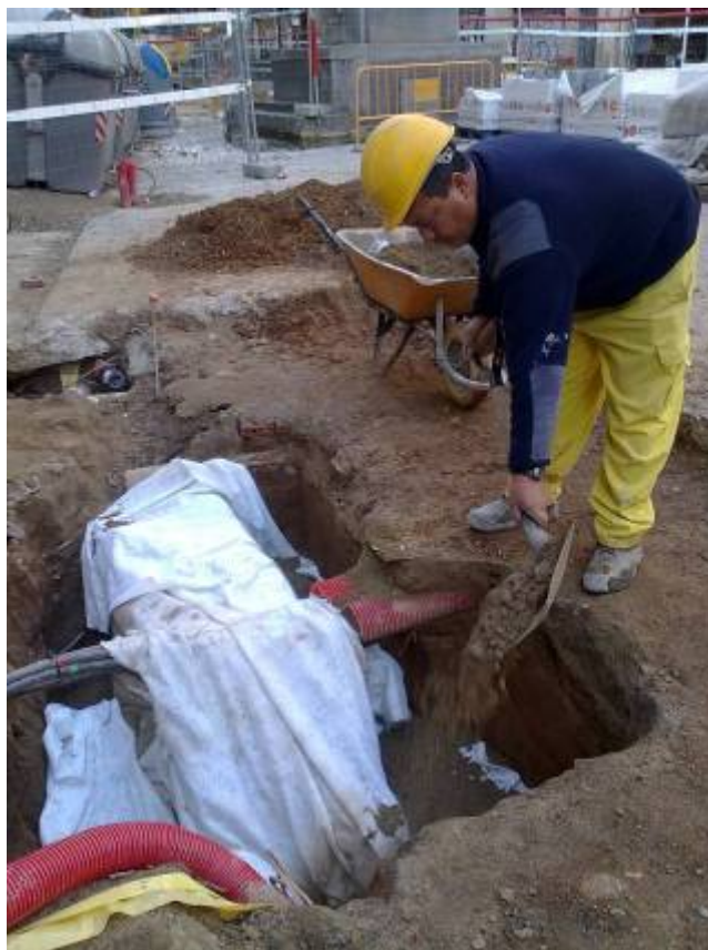
Foto 117: Cobriment del mur UE 288
