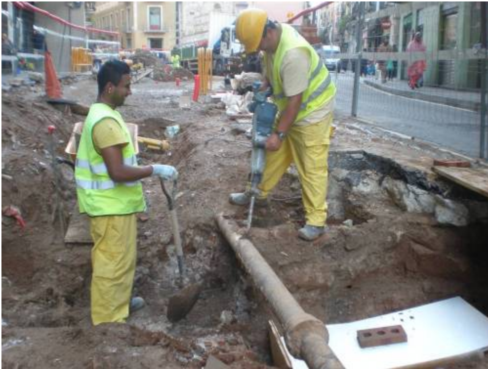
Foto 359: Demolició de la claveguera UE 219
