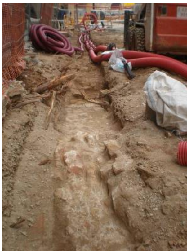
Foto 525: Final de la rasa d'electricitat abans del cobriment indefinit de les restes
