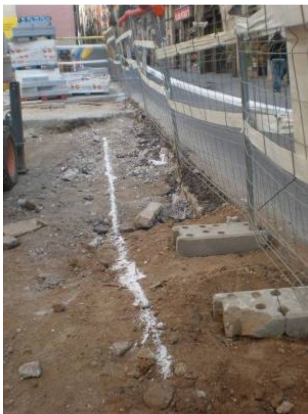
Foto 508: Inicial del següent tram de rasa entre E6 i E6a. Est
