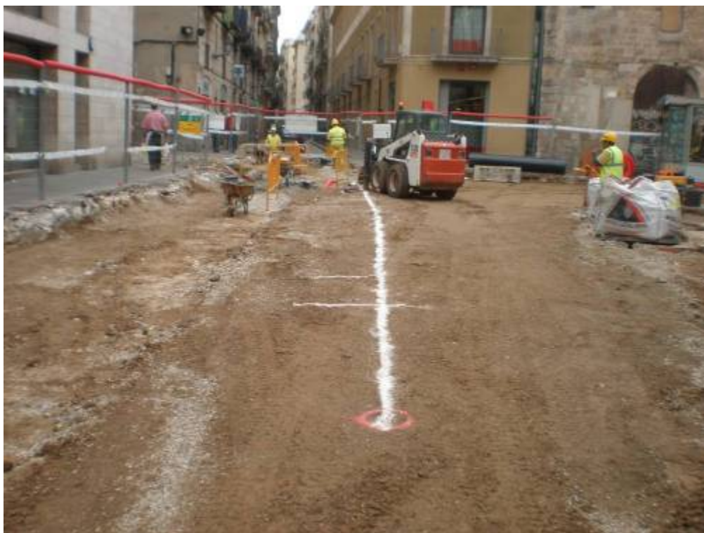
Foto 67: Inicial de la rasa nord a la plaça del Pedró
