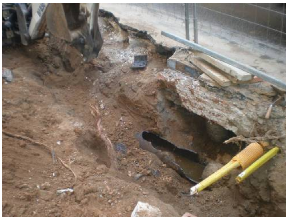
Foto 488: Procés d'excavació mecànica de la rasa entre E5 i E6
