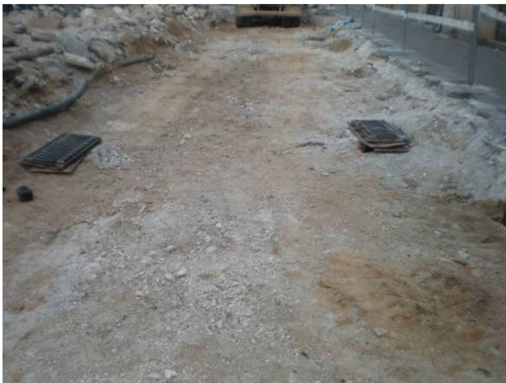
Foto 20: Retirada del paviment
