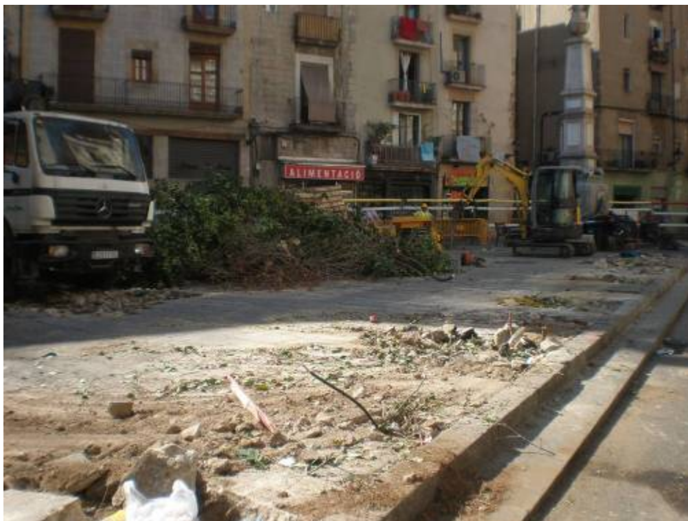
Foto 15: Plaça del Pedró. Retirada dels arbres
