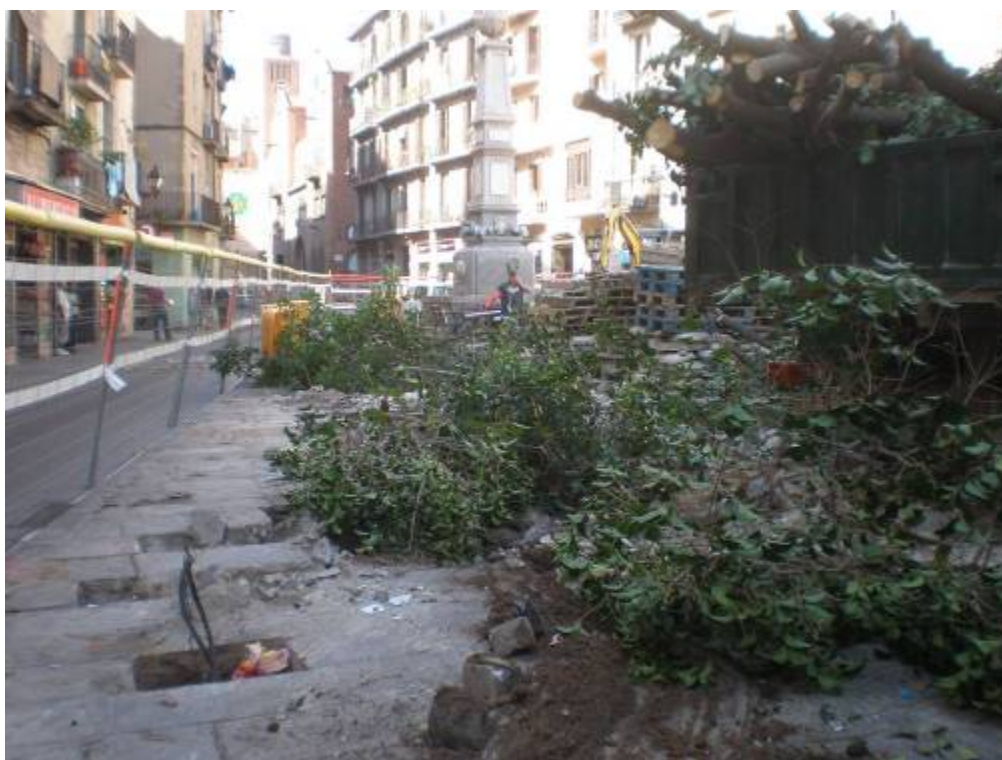
Foto 16: Retirada dels arbres
