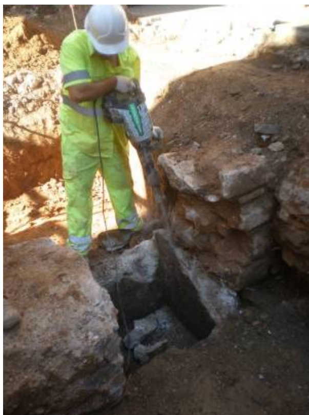
Foto 202: Procés d'eliminació de la UE 171
