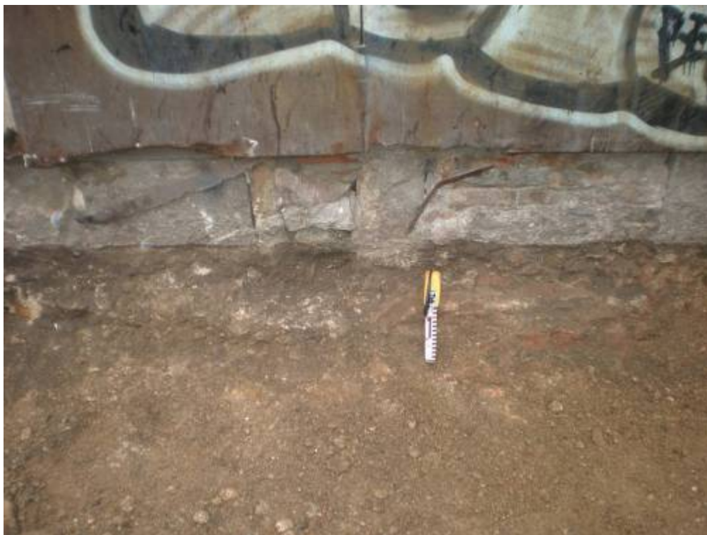
Foto 59: Detall de la fonamentació de l'església de Sant Llàtzer UE 321, a la zona de la porta
