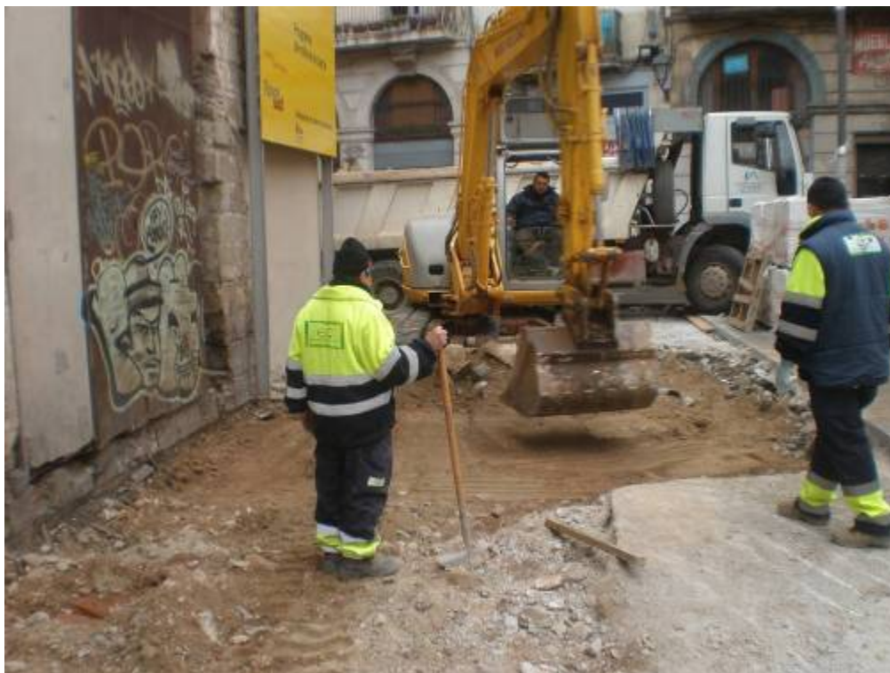
Foto 53: Rebaixos a la zona de la façana de l'església de Sant Llàtzer a la part restituïda durant els anys 90
