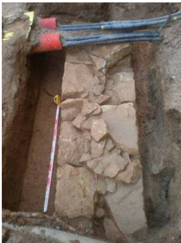
Foto 106: Alçat nord del mur UE 288 a la cota de l'estrat UE 305
