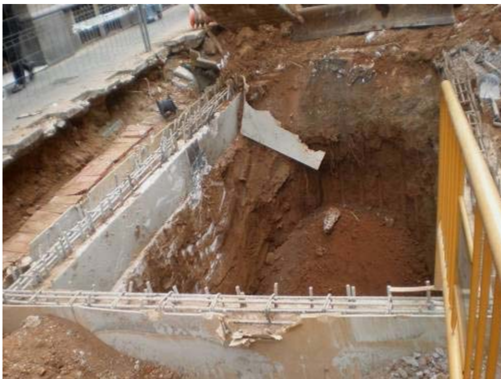
Foto 418: Excavació mecànica al búnker 2. Est
