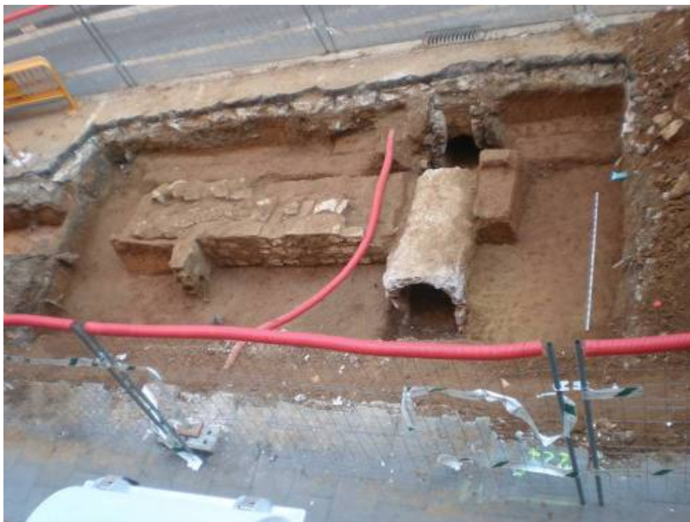
Foto 235: Estat del búnker 1 després de l'excavació del contorn
