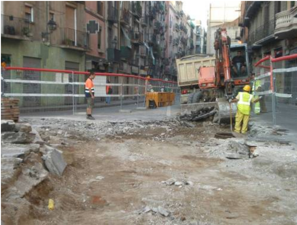
Foto 23: Extracció del paviment al carrer Sant Antoni Abat
