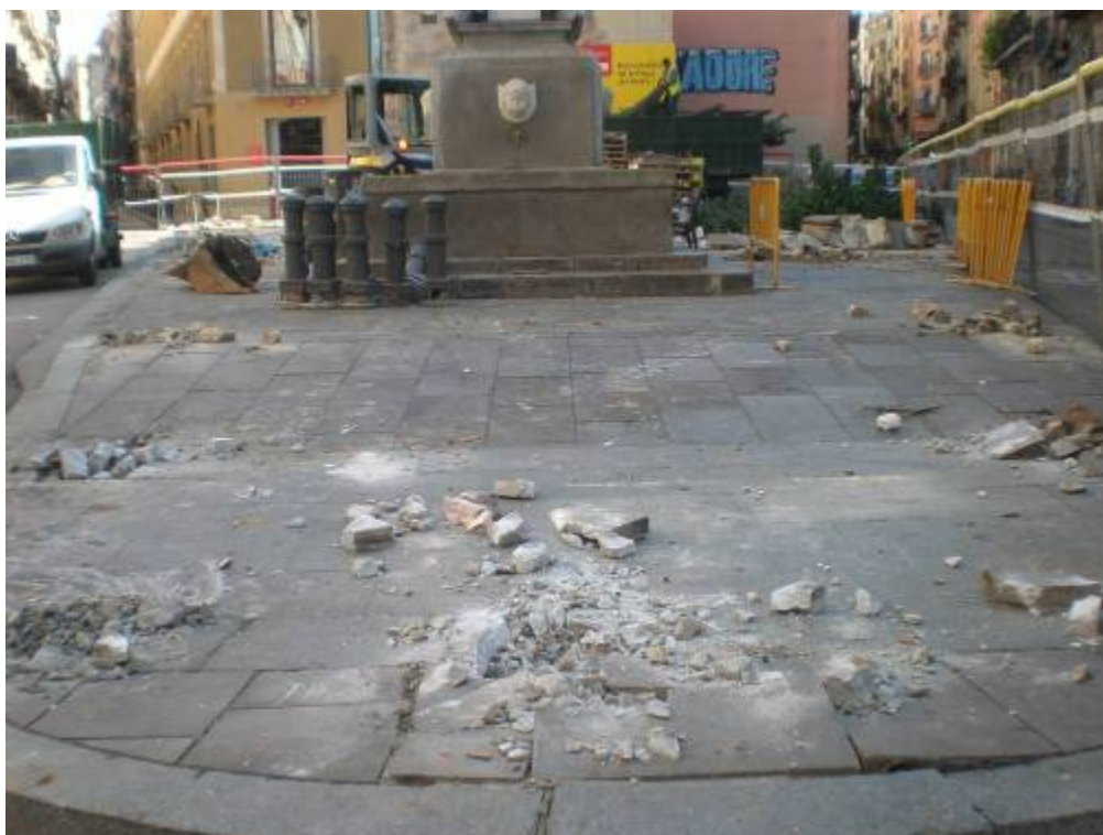
Foto 17: Extracció del paviment
