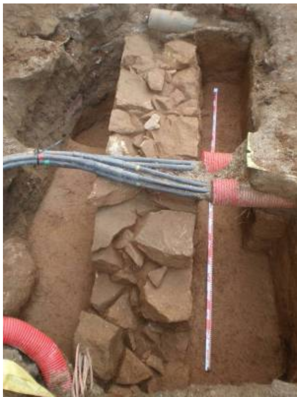
Foto 111: Mur UE 288 final
