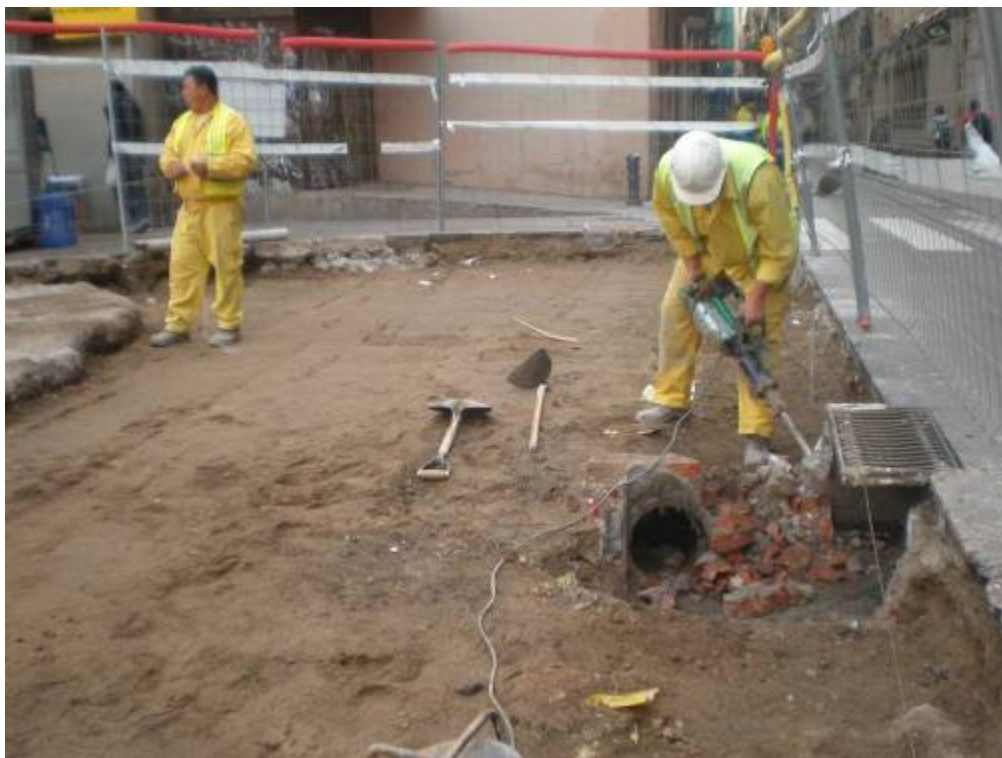
Foto 90: Demolició d'un embornal antic per a la seva futura ampliació
