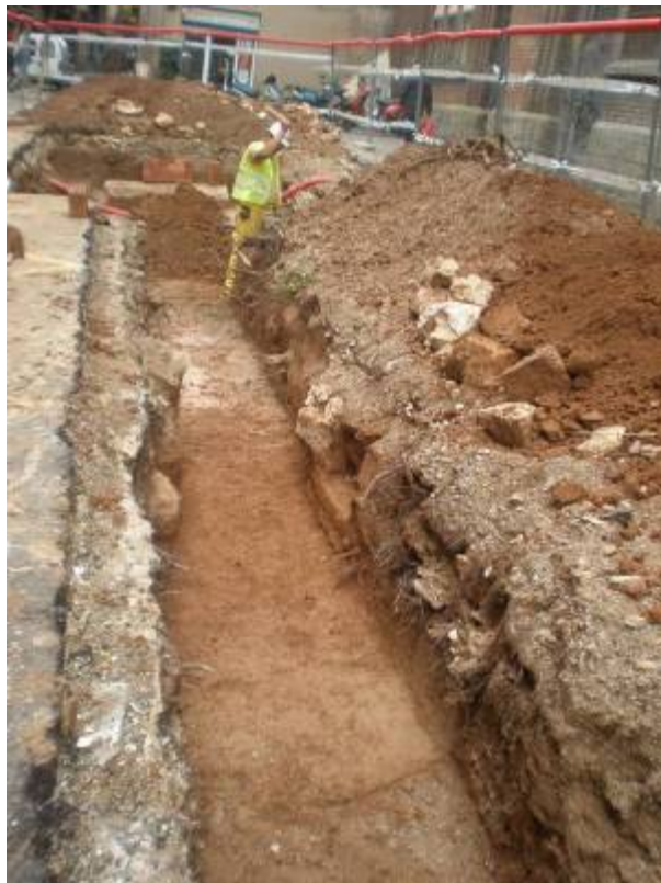
Foto 299: Excavació de la UE 195 en el tram de rasa entre el B1 i el carrer del Bisbe Laguarda. Direcció oest
