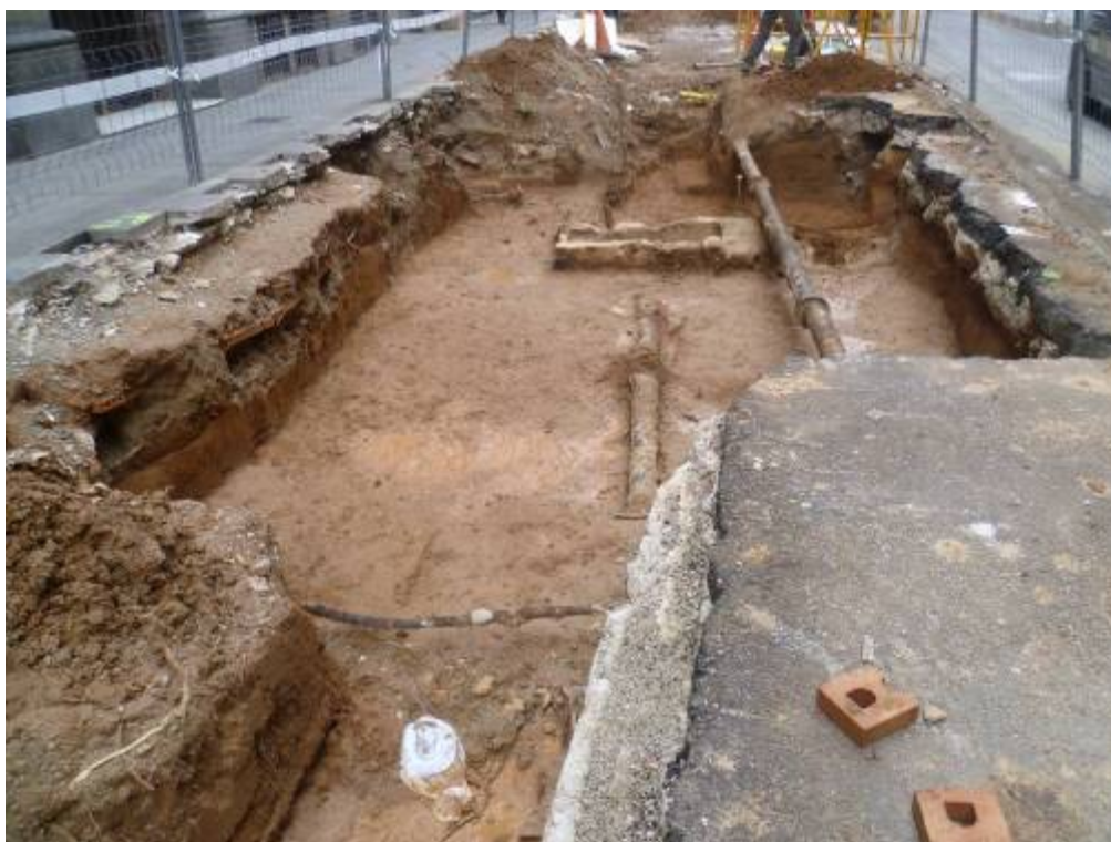
Foto 414: Final de l'excavació manual al búnker 2. Est
