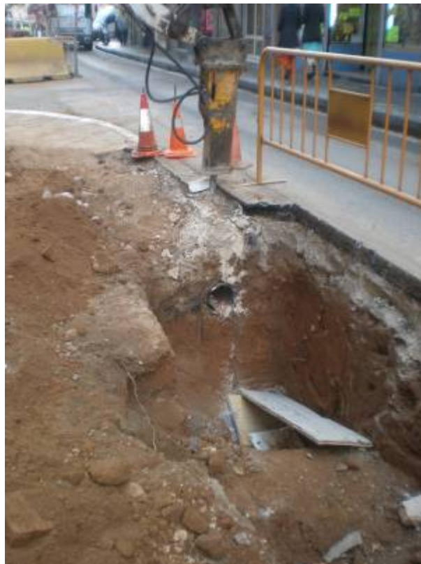
Foto 438: E3. Sistema de cobriment provisional de la UF 7
