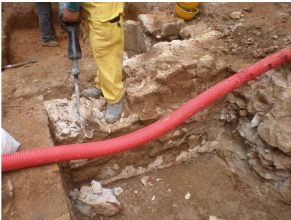
Foto 226: Eliminació del mur UE 174
