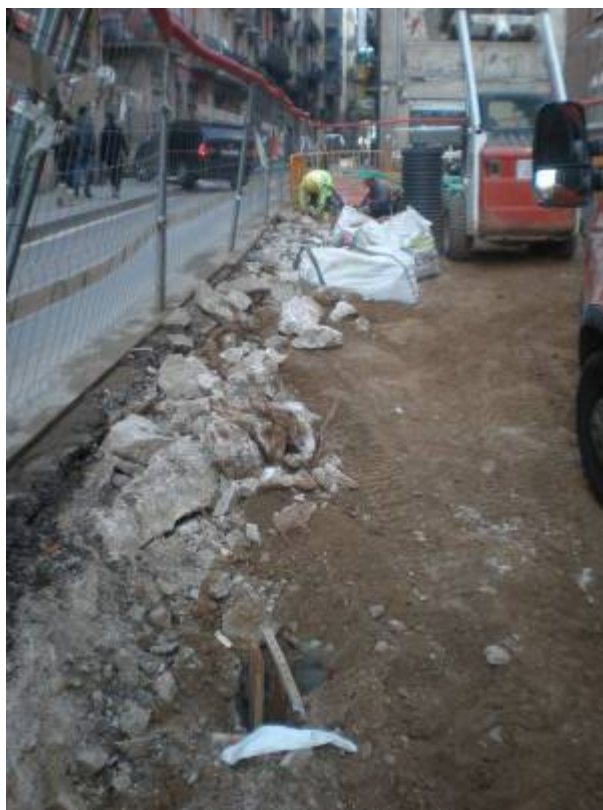
Foto 431: Inicial de la rasa entre E2 i E3. Oest
