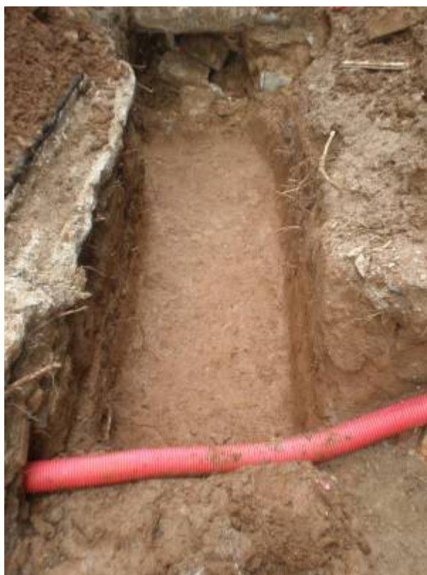
Foto 302: Final de l'excavació de la UE 195 en el tram de rasa des del carrer del Bisbe Laguarda i el B2. Direcció oest
