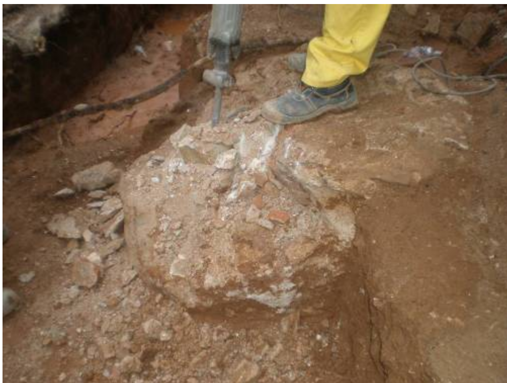
Foto 344: Demolició del pilar UE 116
