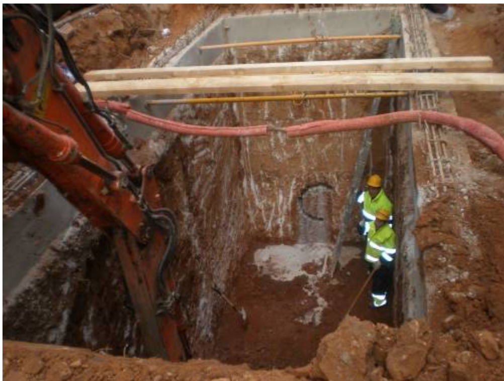
Foto 247: Final de l'excavació del búnker 1
