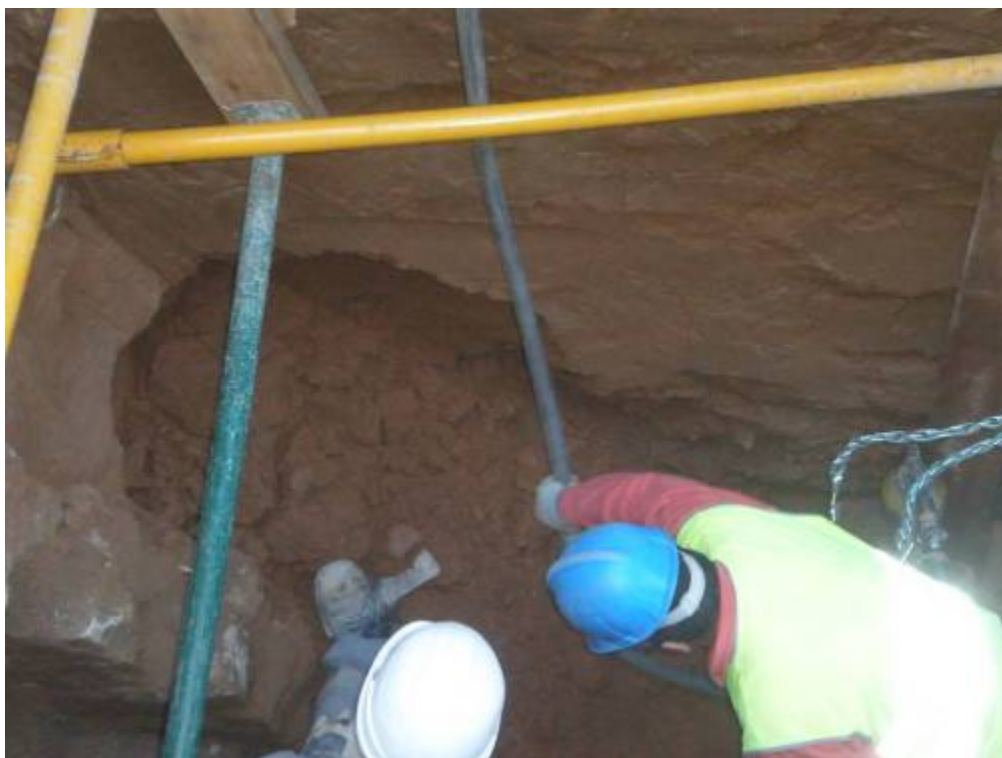
Foto 322: Inici del procés de minat per sota del carrer del Bisbe Laguarda
