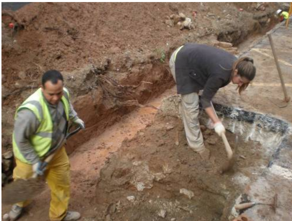
Foto 237: Excavació de l'ampliació a 1 metre
