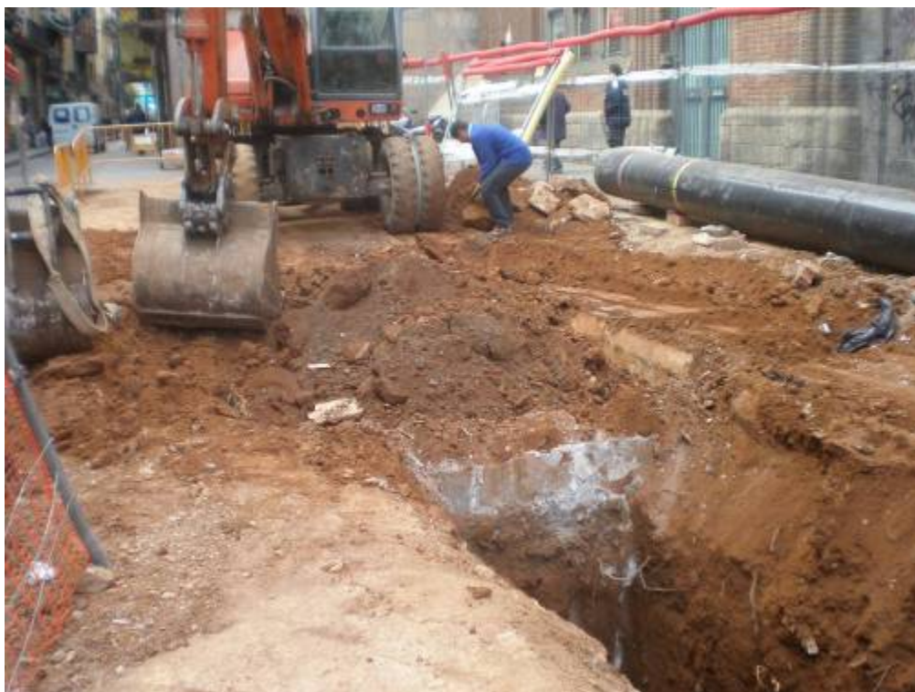
Foto 242: Excavació dels farciments contemporanis després dels murs pantalla
