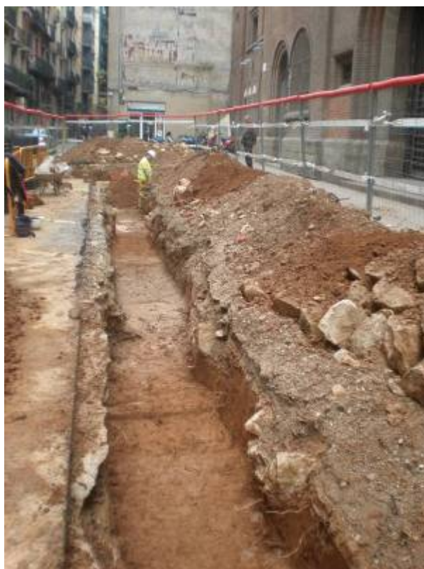
Foto 298: Excavació de la UE 195 en el tram de rasa entre el B1 i el carrer del Bisbe Laguarda. Direcció oest
