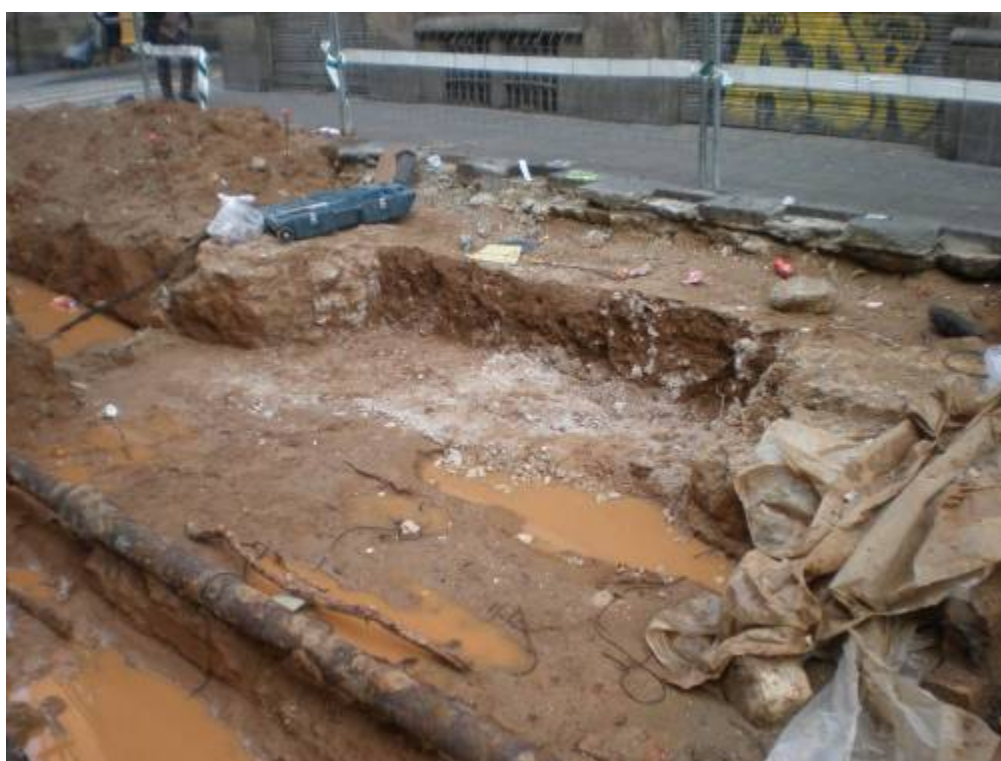
Foto 336: Final de la demolició del mur UE 118
