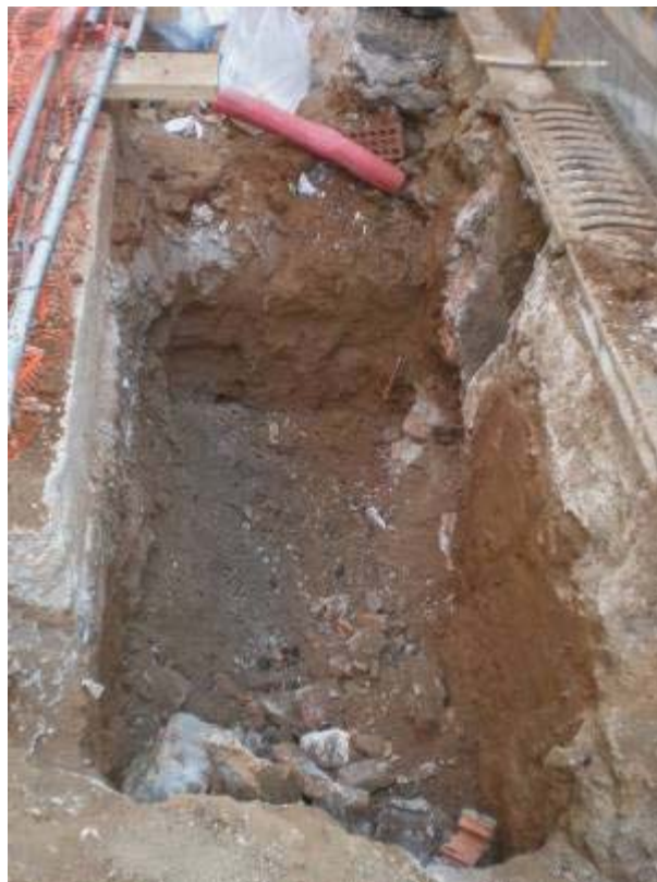
Foto 424: Procés d'excavació de l'embornal 1. Est
