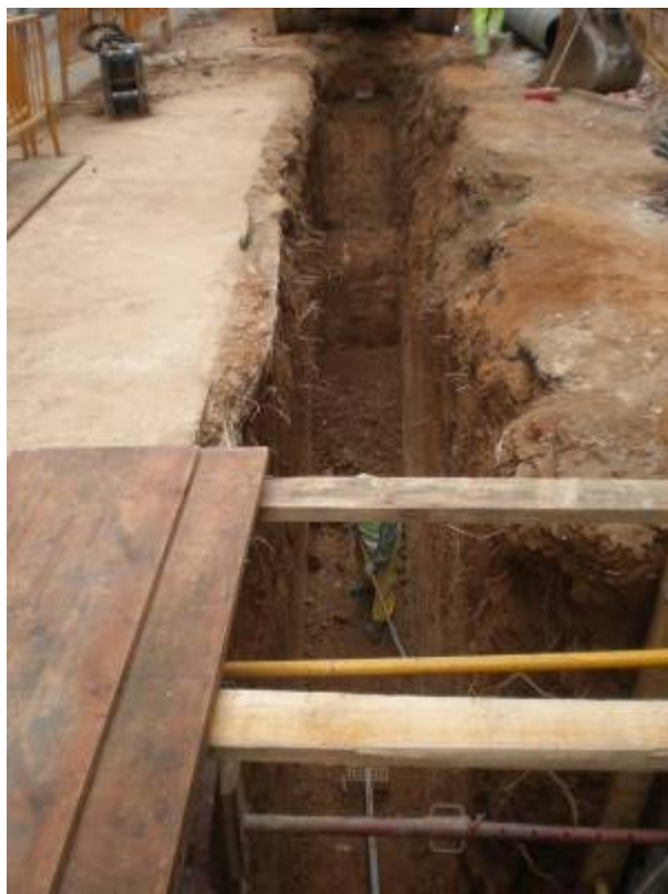
Foto 313: Tram de rasa entre el carrer del Bisbe Laguarda i el B1 en el punt d'aparició del torturà UE 310. Direcció oest. Al fons col·lector UE 311
