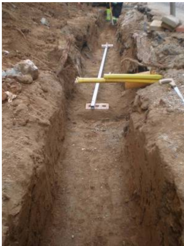
Foto 489: Final de la rasa entre E5 i E6
