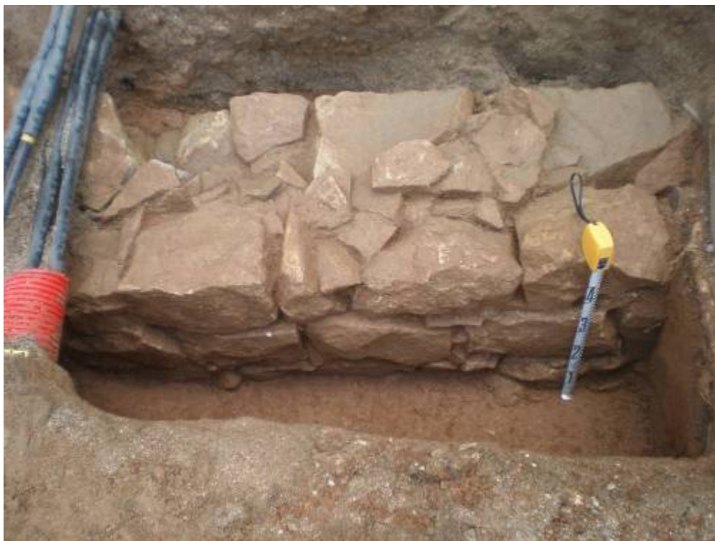
foto 105: Alçat nord del mur UE 288 a la cota de l'estrat UE 305
