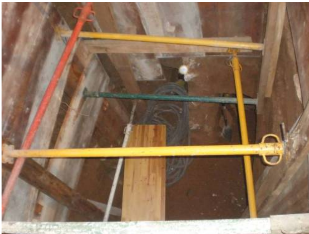
Foto 323: Procés de minat per sota del carrer del Bisbe Laguarda
