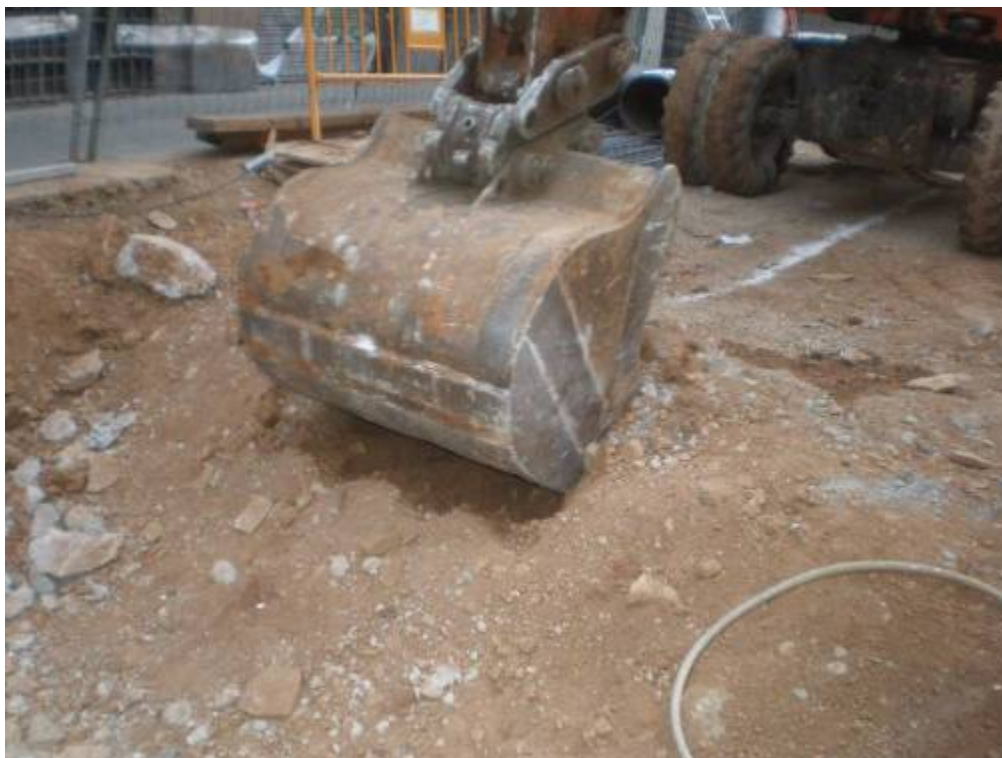
Foto 185: Excavació mecànica fins els 4 m de fondària del tram de rasa fins búnker 2
